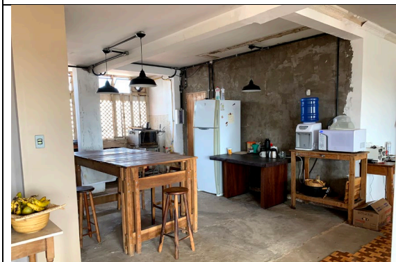
Foto 05. Vista da cozinha em reforma.
