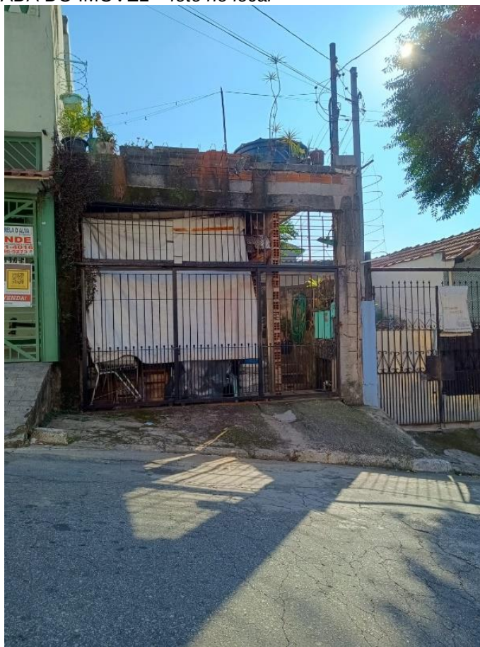
Figura 4- Fachada do imóvel
