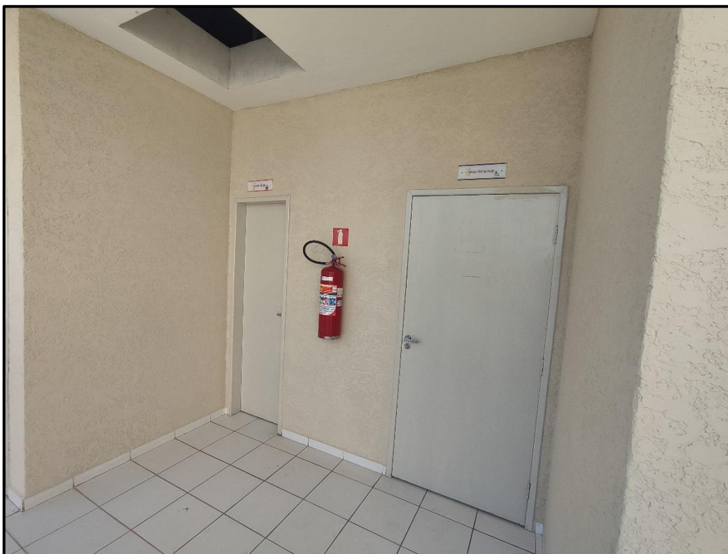
Ilustração 13: Área comum do condomínio – Sanitários
