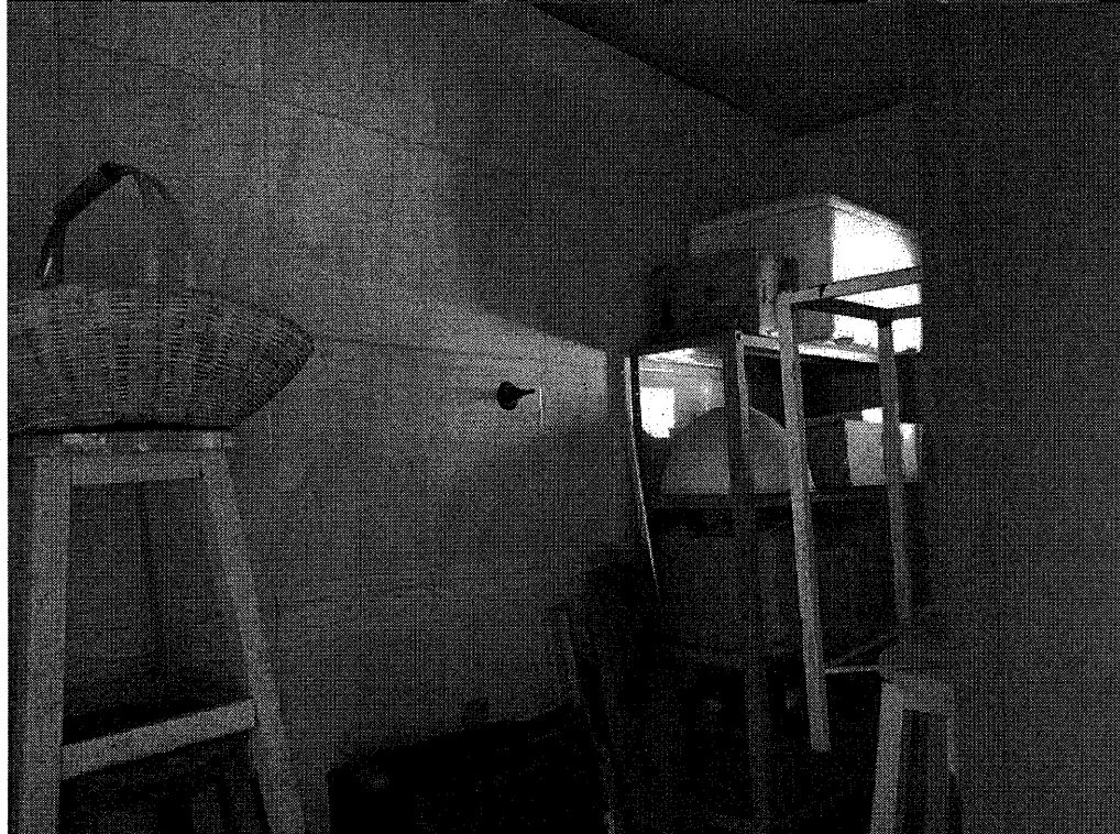
Banheiro — s/ acabamento teto e piso
