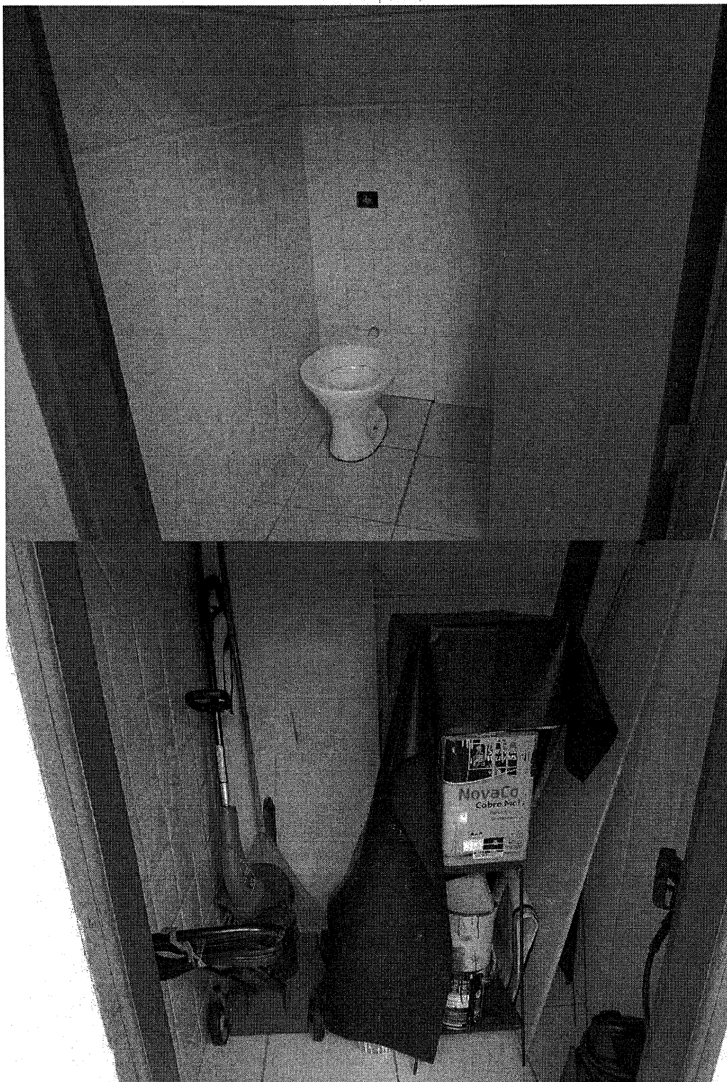
Banheiros – – s/ acabamento teto, s/ metais, 01 sem louças
