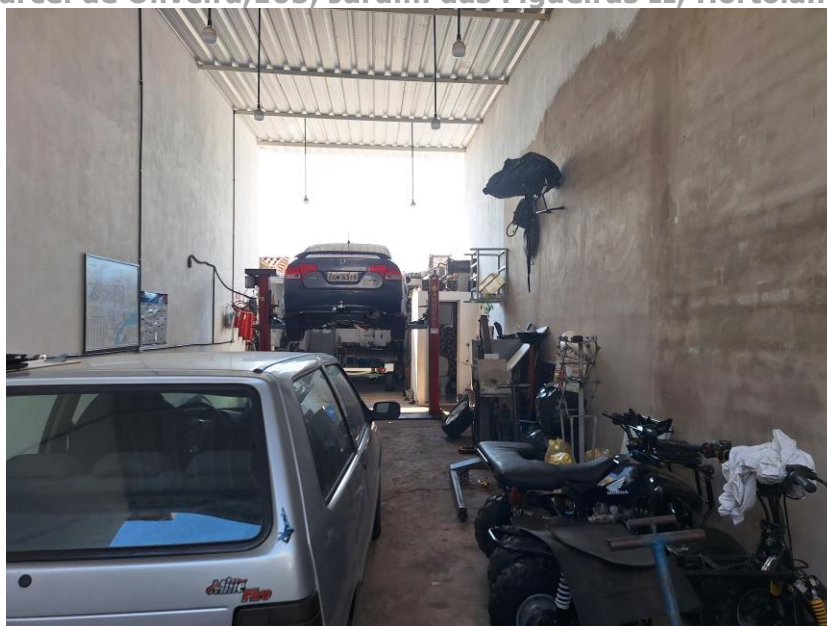
Imagem 25 – Vista Interna – OFICINA MECÂNICA. Paredes em alvenaria / reboco / parte com acabamento em pintura. Piso cimentado. Cobertura em estrutura metálica. Vista para carros em espera e em manutenção.
