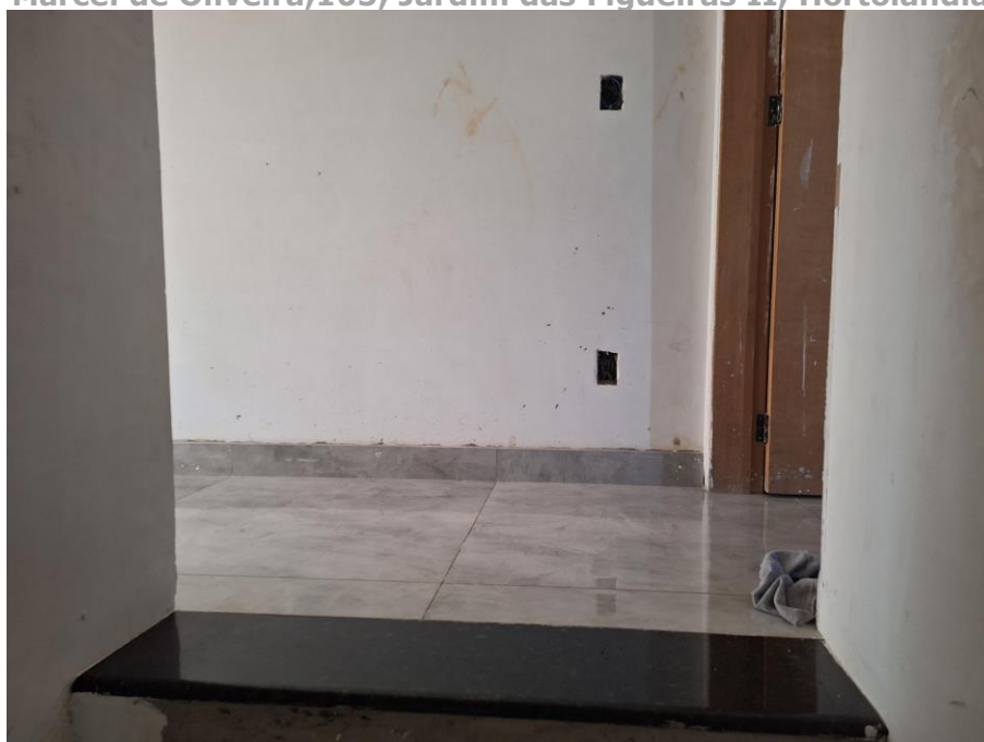
Imagem 63 – Vista Interna – CIRCULAÇÃO. Chegada pela escada ao piso superior. Paredes em alvenaria / reboco / pintura. Piso cerâmico. Esquadrias em madeira. Acesso franqueado pelo Executado.
