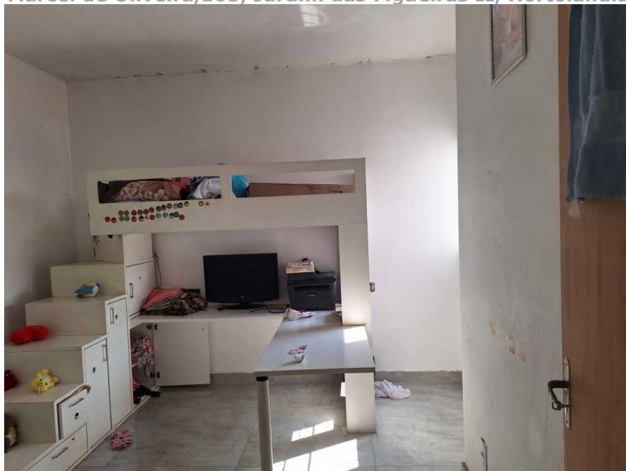
Imagem 67 – Vista Interna – DORMITÓRIO. Paredes em alvenaria / reboco / pintura. Piso cerâmico. Esquadrias em madeira e alumínio.
