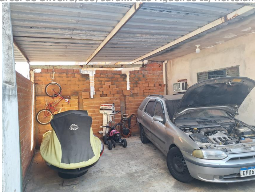
Imagem 23 – Vista Interna – OFICINA MECÂNICA. Paredes em alvenaria / reboco / parte com acabamento em pintura. Piso cimentado. Cobertura em estrutura metálica. Vista para carros em espera e em manutenção.
