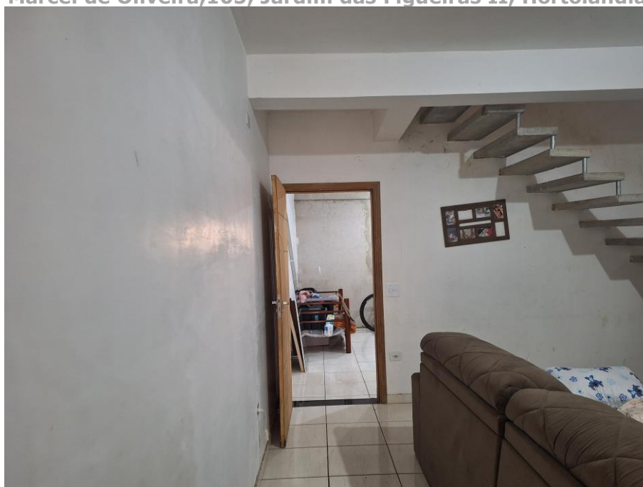
Imagem 51 – Vista Interna – SALA. Vista para porta de acesso ao dormitório. Paredes em alvenaria / reboco / pintura. Piso cerâmico. Porta em madeira.
