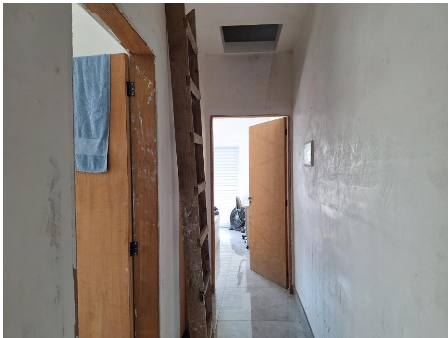
Imagem 72 – Vista Interna – CIRCULAÇÃO. Vista para porta de acesso ao dormitório. Paredes em alvenaria / reboco / pintura. Piso cerâmico. Esquadrias em madeira.
