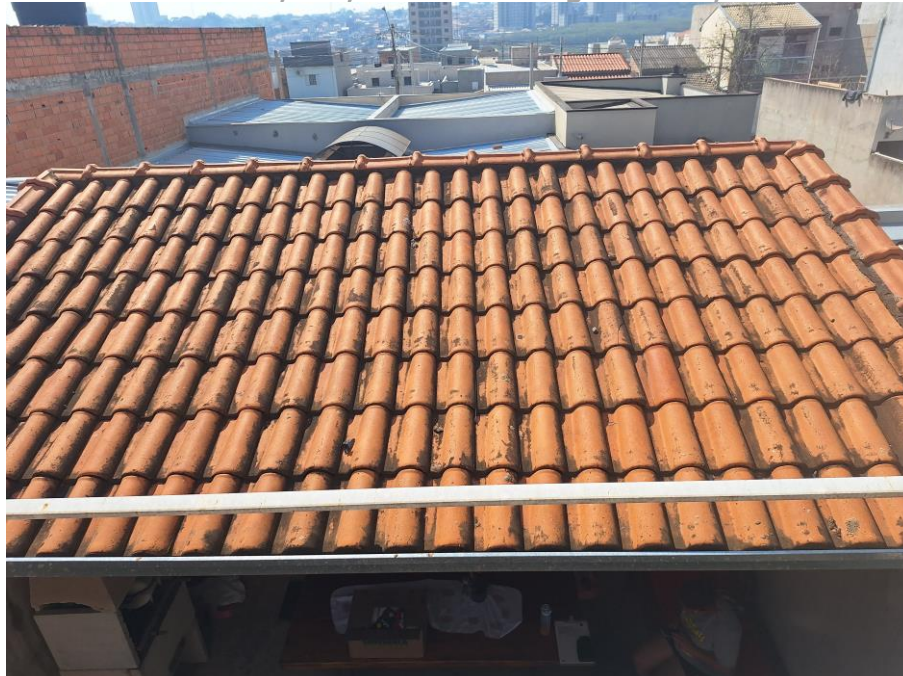
Imagem 82 – Vista Interna – SACADA DORMITÓRIO. Paredes em alvenaria / reboco (obra não finalizada). Piso cerâmico. Esquadrias em madeira e alumínio. Vista para coberturas e área inferior (térreo). Acesso franqueado pelo Executado.
