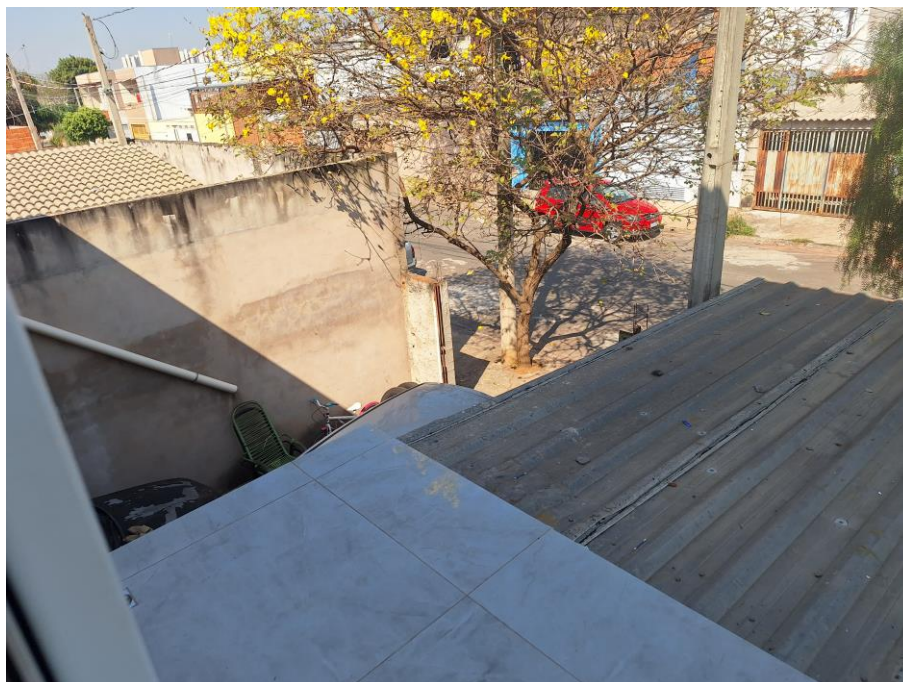
Imagem 106 – Vista Interna – SACADA. Sacada da suíte. Piso porcelanato. (Obra não finalizada). Vista para coberturas e áreas do piso inferior (térreo). Acesso franqueado pelo Executado.
