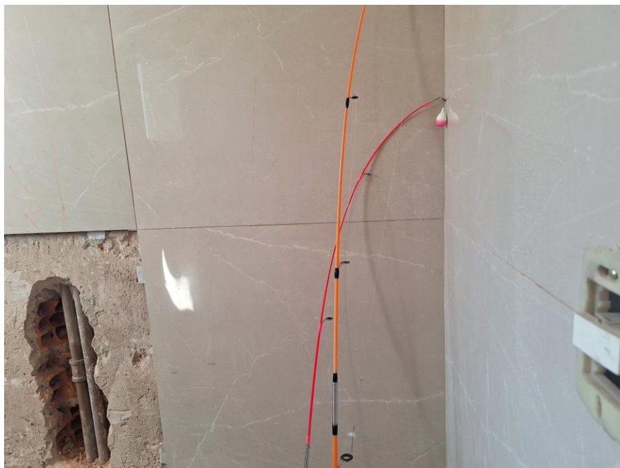
Imagem 90 – Vista Interna – BANHEIRO. Paredes em alvenaria / reboco / revestimento porcelanato. Piso porcelanato. Obra em andamento.
