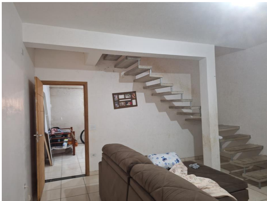
Imagem 50 – Vista Interna – SALA. Paredes em alvenaria / reboco / pintura. Piso cerâmico. Porta em madeira. Acesso franqueado pelo Executado.
