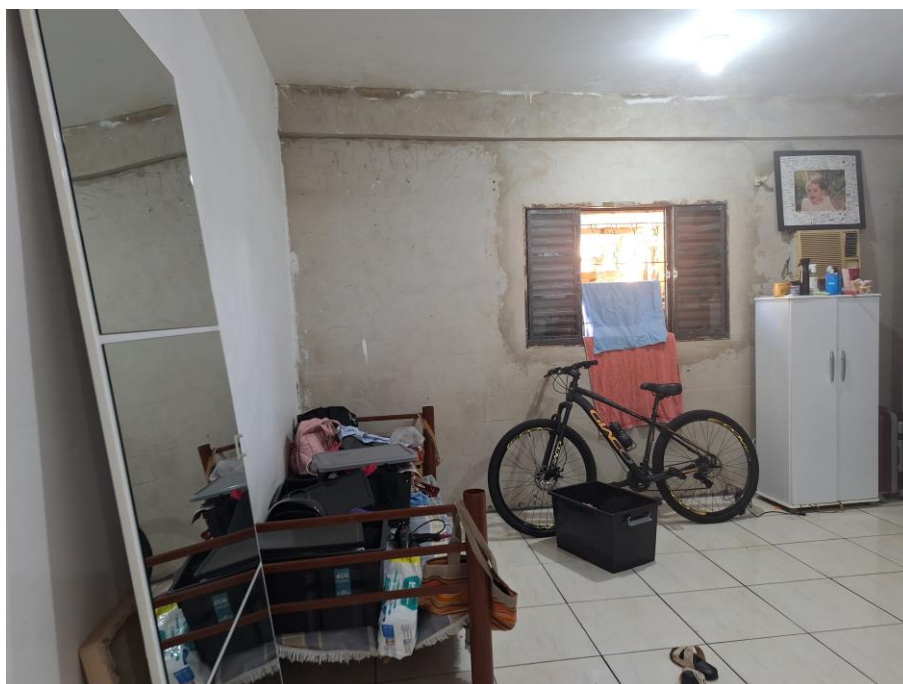
Imagem 52 – Vista Interna – DORMITÓRIO. Paredes em alvenaria / reboco / parte em pintura (obra não finalizada). Piso cerâmico. Esquadrias em ferro e madeira. Acesso franqueado pelo Executado.
