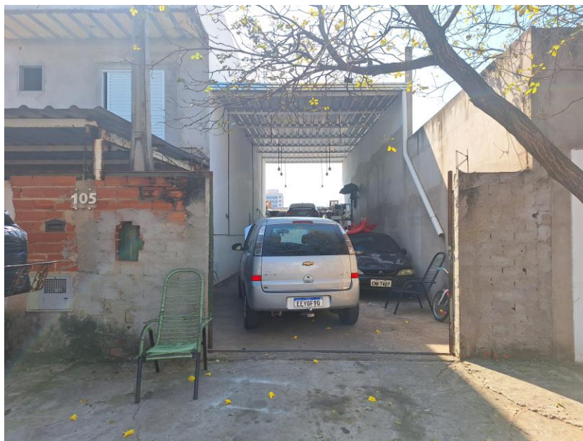
Imagem 18 – Vista Externa – Fachada Principal. Visão pela rua frontal. Muro em alvenaria / parte com reboco (obra não finalizada). Piso cimentado. Portão metálico. Entrada pelo portão frontal. Acesso franqueado pelo Executado.
