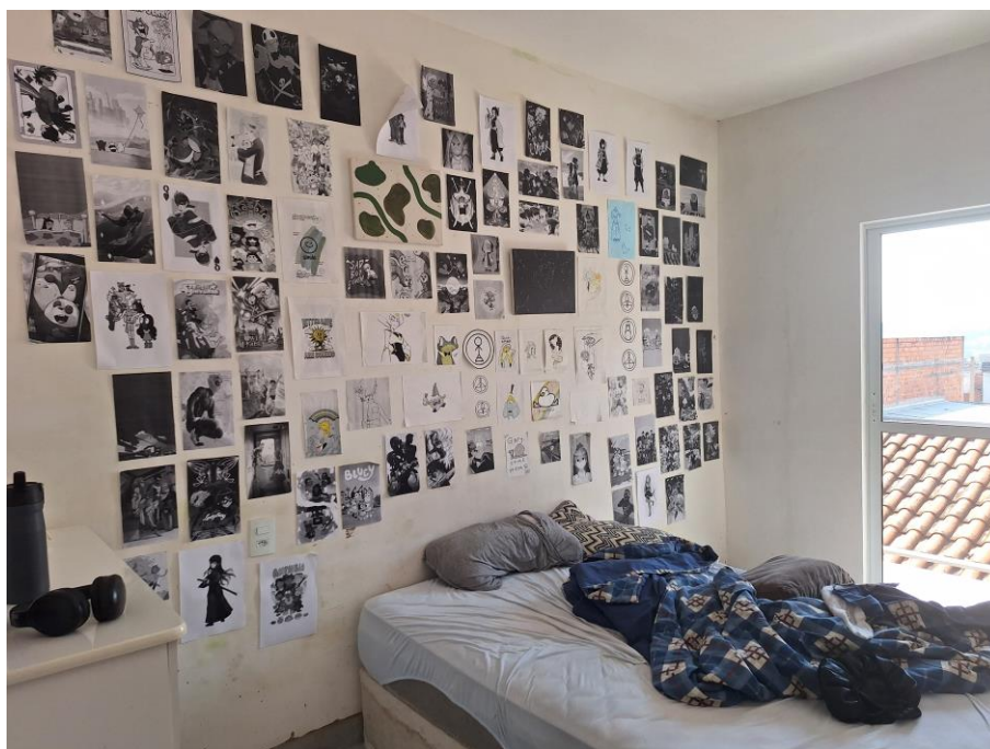
Imagem 74 – Vista Interna – DORMITÓRIO. Paredes em alvenaria / reboco / pintura. Piso cerâmico. Esquadrias em madeira e alumínio. Acesso franqueado pelo Executado.
