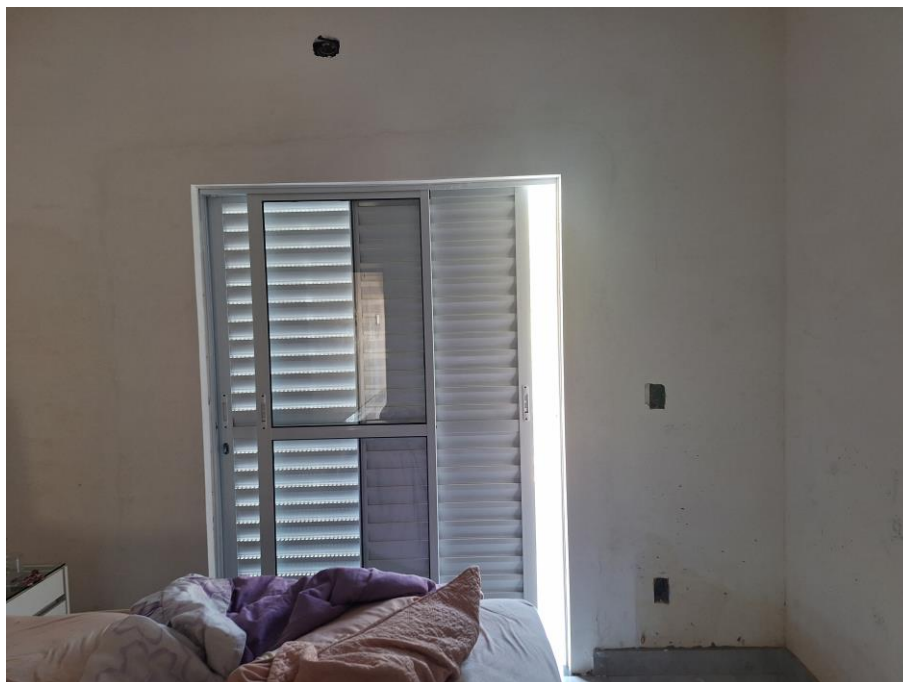
Imagem 104 – Vista Interna – SUÍTE. Vista para porta de acesso à sacada da suíte. Paredes em alvenaria / reboco / pintura. Piso cerâmico. Esquadrias em alumínio. Acesso franqueado pelo Executado.
