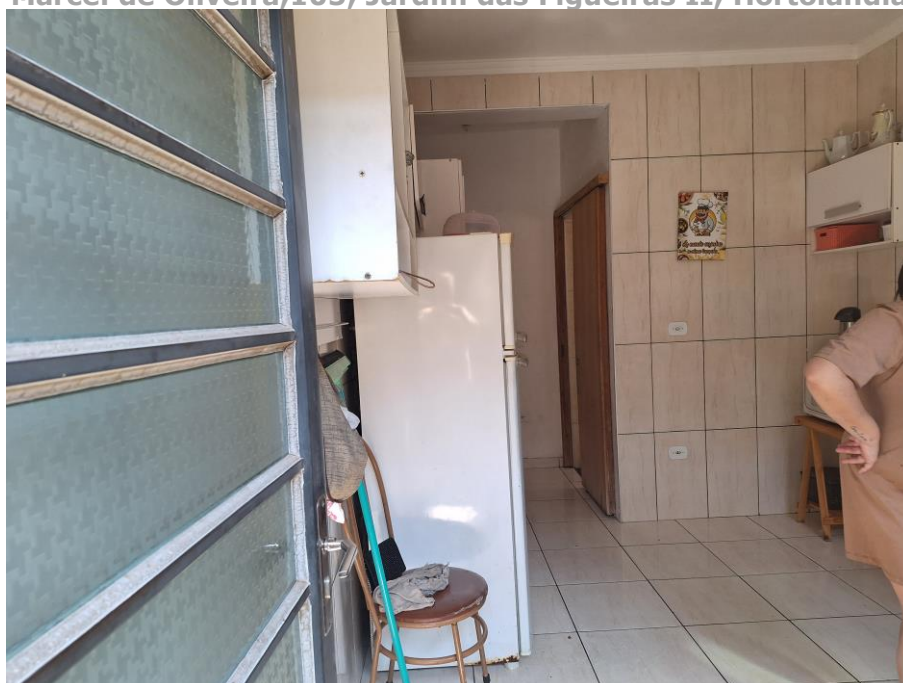
Imagem 43 – Vista Interna – COZINHA. Paredes em alvenaria / reboco / revestimento cerâmico. Piso cerâmico. Esquadrias em ferro e vidro. Acesso franqueado pelo Executado.
