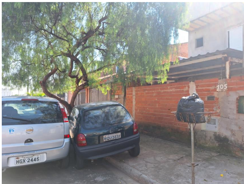
Imagem 14 – Vista Externa – Fachada Principal. Visão pela rua frontal. Acesso franqueado pelo Executado.
