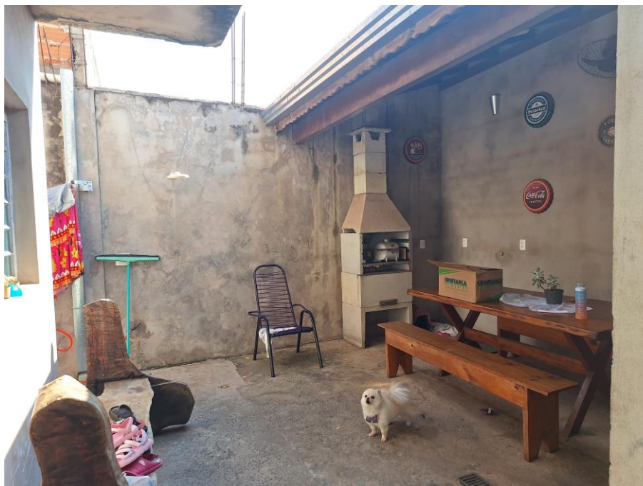
Imagem 36 – Vista Interna – ÁREA DE LAZER. Vista para área de lazer / churrasqueira da residência. Paredes em alvenaria / reboco (obra não finalizada). Piso cimentado. Cobertura em telha cerâmica e estrutura em madeira.
