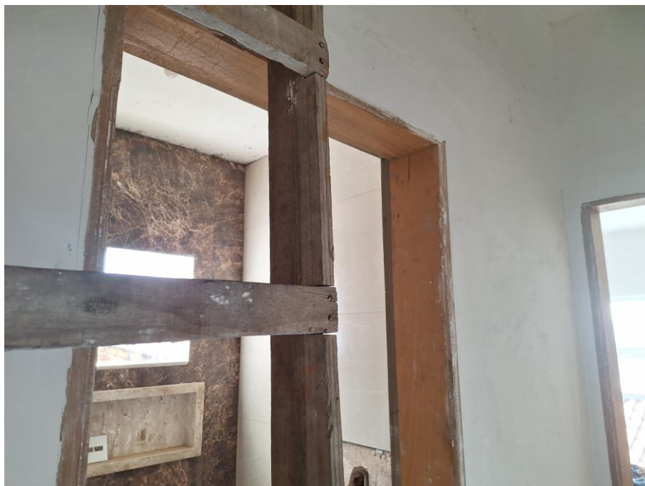
Imagem 86 – Vista Interna – CIRCULAÇÃO. Paredes em alvenaria / reboco / pintura. Piso cerâmico. Esquadrias em madeira. Acesso franqueado pelo Executado.
