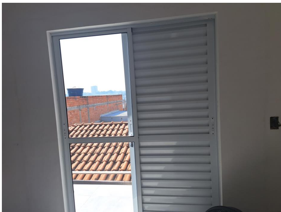
Imagem 78 – Vista Interna – DORMITÓRIO. Vista para porta de acesso à sacada. Paredes em alvenaria / reboco / pintura. Piso cerâmico. Esquadrias em madeira e alumínio. Acesso franqueado pelo Executado.
