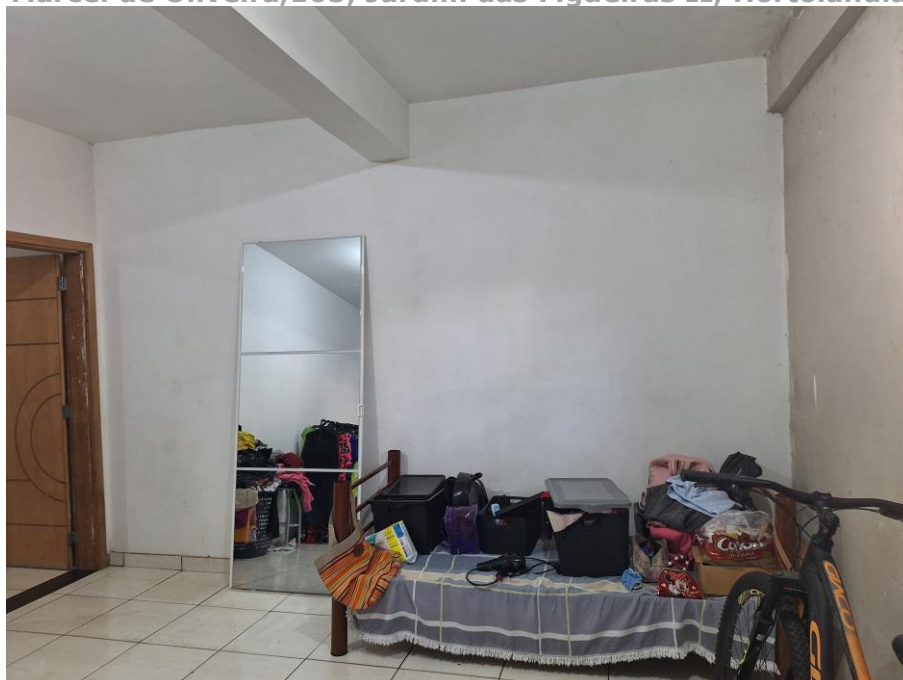
Imagem 55 – Vista Interna – DORMITÓRIO. Paredes em alvenaria / reboco / parte em pintura (obra não finalizada). Piso cerâmico. Esquadrias em ferro e madeira. Acesso franqueado pelo Executado.
