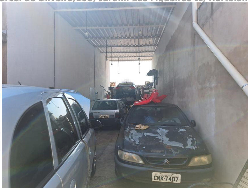
Imagem 19 – Vista Interna – OFICINA MECÂNICA. Paredes em alvenaria / reboco / parte com acabamento em pintura. Piso cimentado. Cobertura em estrutura metálica. Vista para carros em espera e em manutenção.
