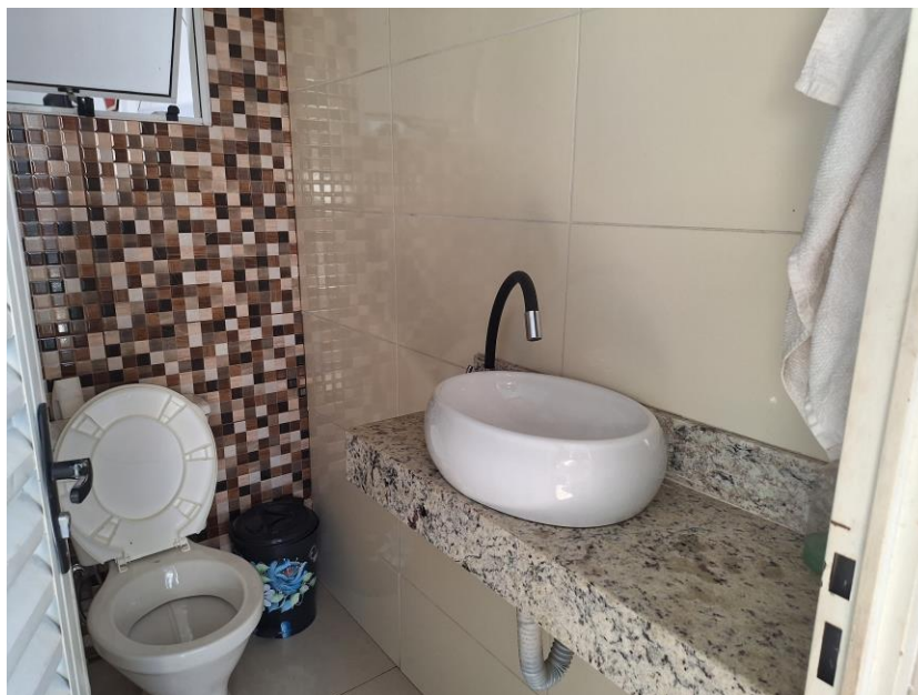
Imagem 28 – Vista Interna – OFICINA MECÂNICA. Vista para o lavabo da oficina. Piso cerâmico. Parede em alvenaria / reboco / revestimento cerâmico. Esquadria em alumínio. Acesso franqueado pelo Executado.
