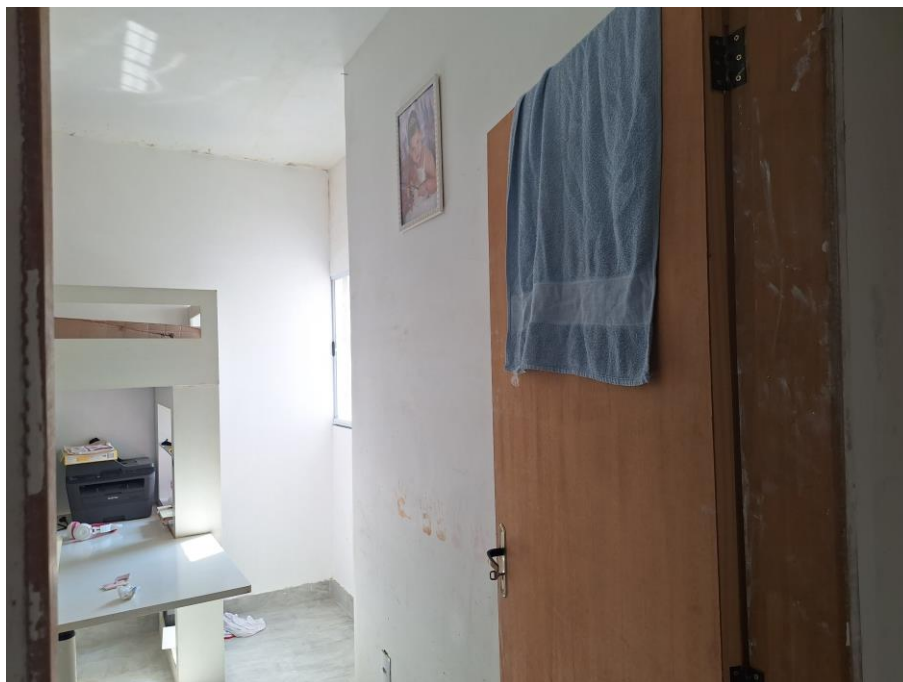
Imagem 66 – Vista Interna – CIRCULAÇÃO. Vista para porta de acesso ao dormitório. Paredes em alvenaria / reboco / pintura. Piso cerâmico. Esquadrias em madeira.
