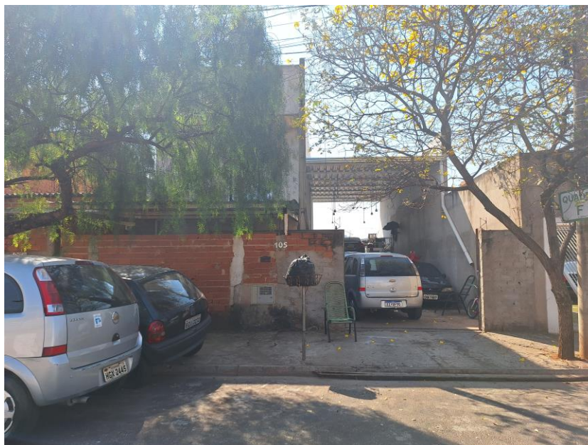
Imagem 12 – Vista Externa – Fachada Principal. Visão pela rua frontal. Acesso franqueado pelo Executado.
