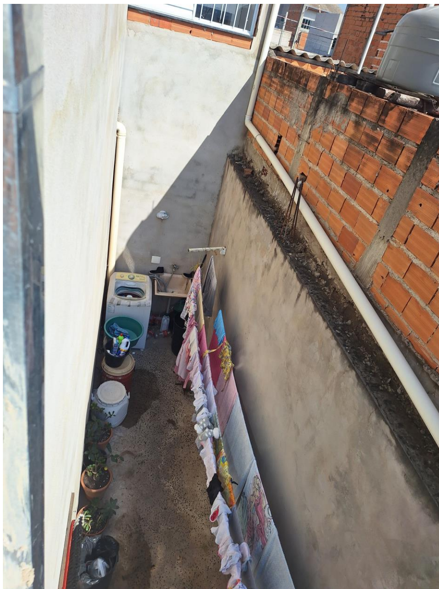
Imagem 80 – Vista Interna – SACADA DORMITÓRIO. Paredes em alvenaria / reboco (obra não finalizada). Piso cerâmico. Esquadrias em madeira e alumínio. Vista para coberturas e área inferior (térreo). Acesso franqueado pelo Executado.
