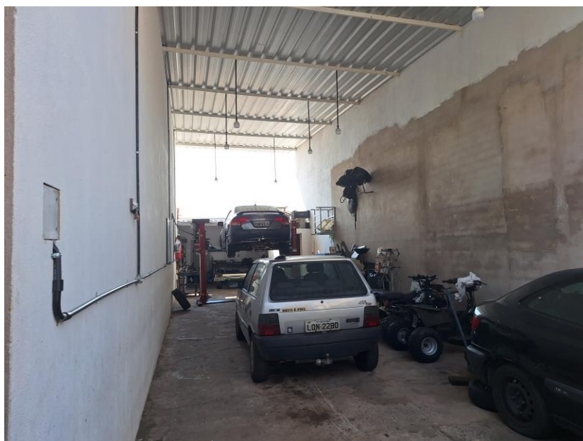
Imagem 24 – Vista Interna – OFICINA MECÂNICA. Paredes em alvenaria / reboco / parte com acabamento em pintura. Piso cimentado. Cobertura em estrutura metálica. Vista para carros em espera e em manutenção.
