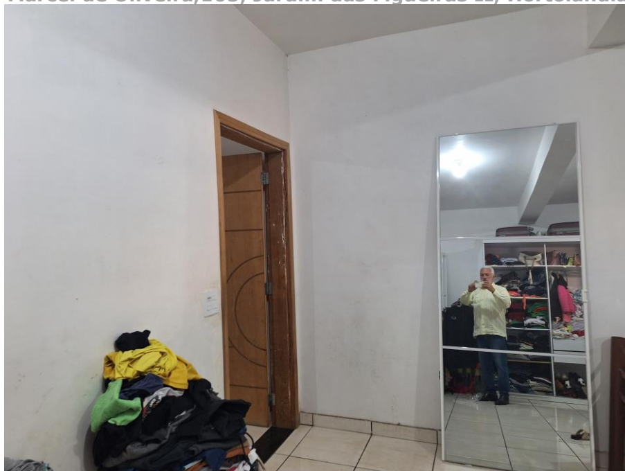
Imagem 57 – Vista Interna – DORMITÓRIO. Paredes em alvenaria / reboco / parte em pintura (obra não finalizada). Piso cerâmico. Esquadrias em ferro e madeira. Acesso franqueado pelo Executado.
