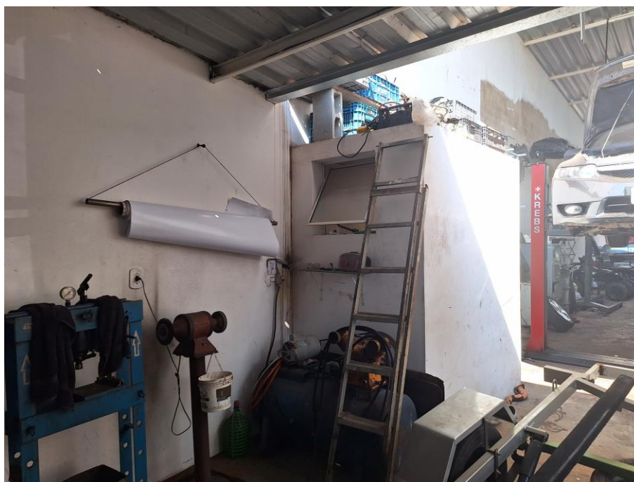
Imagem 32 – Vista Interna – OFICINA MECÂNICA. Vista para depósito de materiais e ferramentas da oficina. Parede em alvenaria / reboco / pintura. Piso cimentado. Cobertura metálica.
