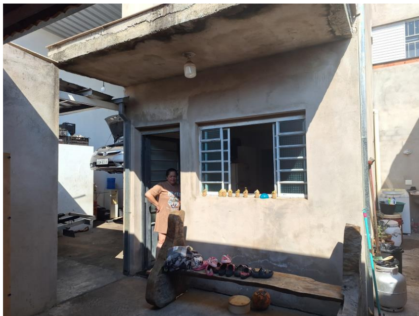
Imagem 40 – Vista Interna – ÁREA DE LAZER. Vista para área de lazer / churrasqueira da residência. Paredes em alvenaria / reboco (obra não finalizada). Piso cimentado. Cobertura em telha cerâmica e estrutura em madeira.
