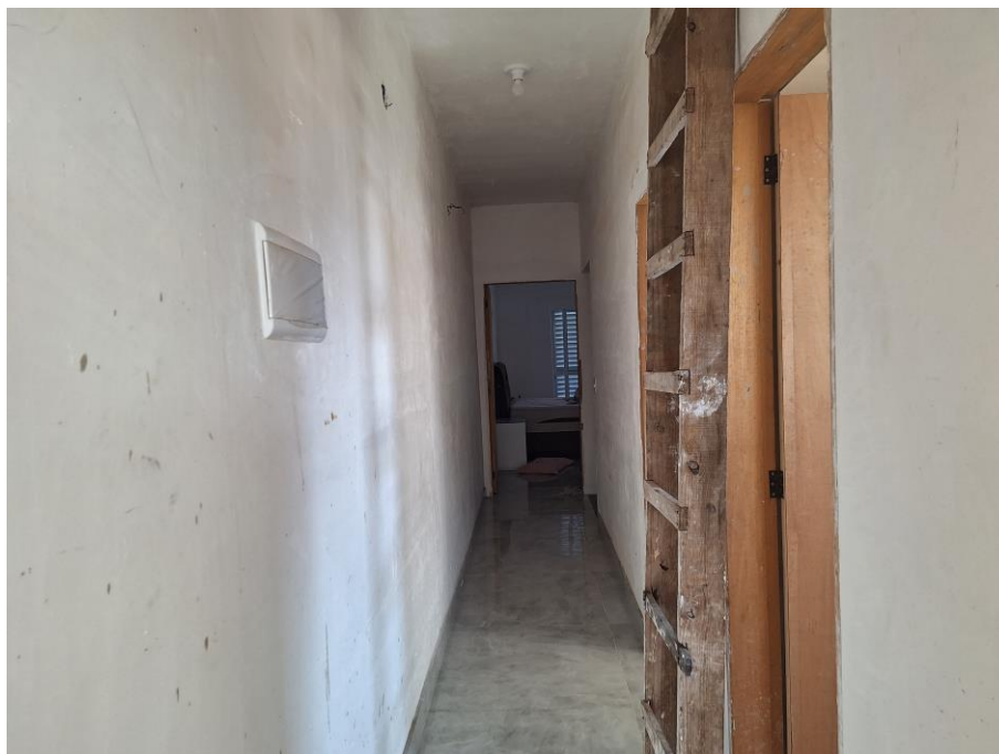
Imagem 92 – Vista Interna – CIRCULAÇÃO. Paredes em alvenaria / reboco / pintura. Piso cerâmico. Esquadrias em madeira. Acesso franqueado pelo Executado.
