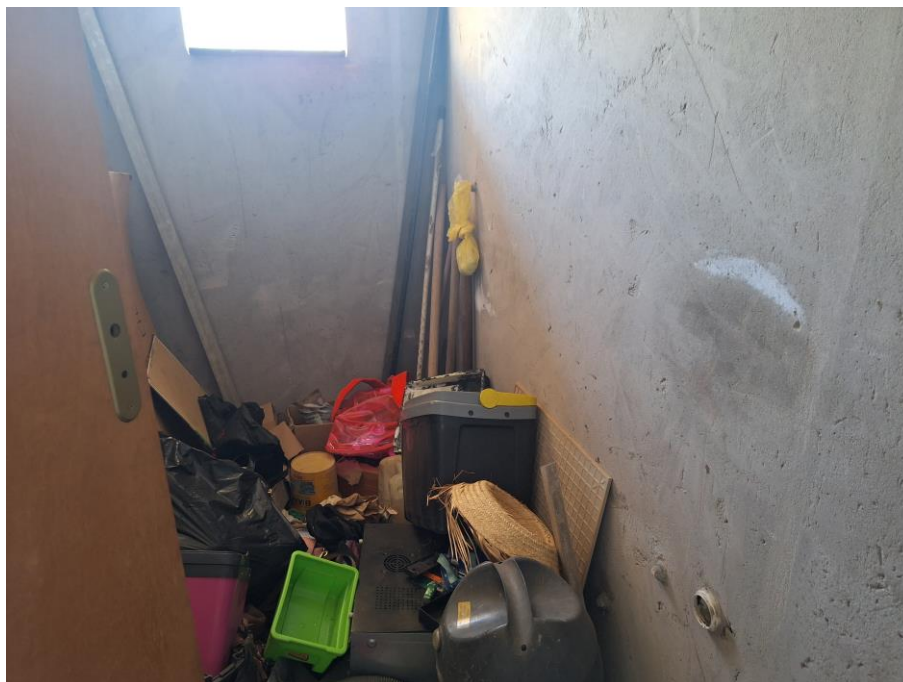
Imagem 102 – Vista Interna – BANHEIRO DA SUÍTE. Paredes em alvenaria / reboco. Piso cimentado (contrapiso). Obra em andamento. Acesso franqueado pelo Executado.
