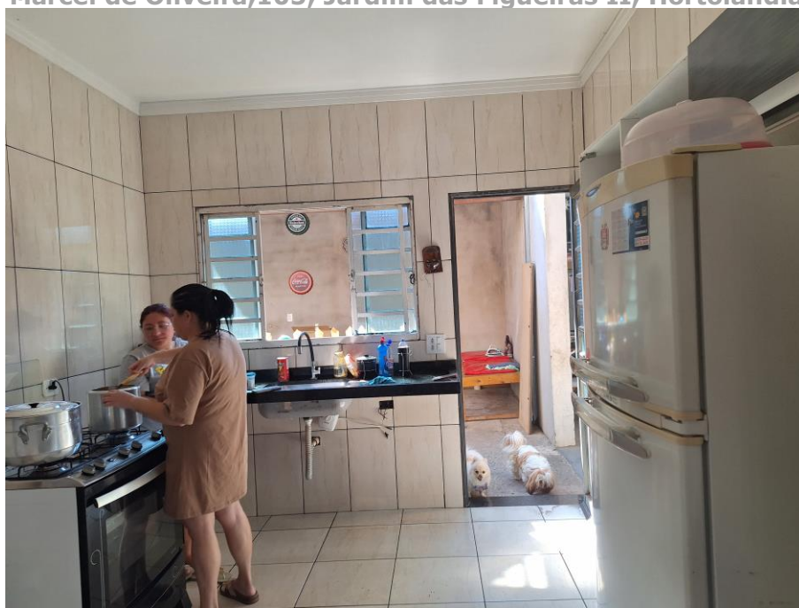
Imagem 45 – Vista Interna – COZINHA. Paredes em alvenaria / reboco / revestimento cerâmico. Piso cerâmico. Esquadrias em ferro e vidro. Acesso franqueado pelo Executado.
