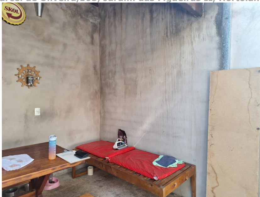
Imagem 39 – Vista Interna – ÁREA DE LAZER. Vista para área de lazer / churrasqueira da residência. Paredes em alvenaria / reboco (obra não finalizada). Piso cimentado. Cobertura em telha cerâmica e estrutura em madeira.
