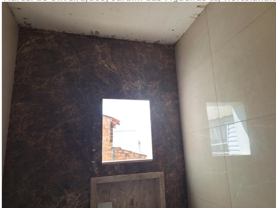
Imagem 91 – Vista Interna – BANHEIRO. Paredes em alvenaria / reboco / revestimento porcelanato. Piso porcelanato. Obra em andamento.
