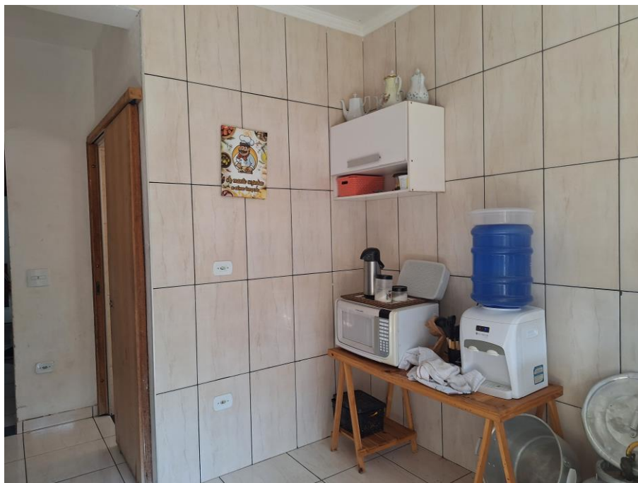
Imagem 44 – Vista Interna – COZINHA. Paredes em alvenaria / reboco / revestimento cerâmico. Piso cerâmico. Esquadrias em ferro e vidro. Acesso franqueado pelo Executado.
