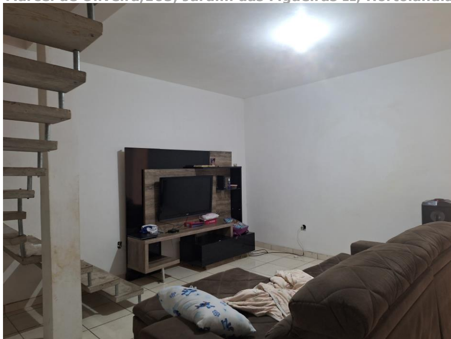
Imagem 59 – Vista Interna – SALA. Paredes em alvenaria / reboco / parte em pintura. Piso cerâmico. Vista para escada de acesso ao piso superior. Escada em concreto e aço. Acesso franqueado pelo Executado.
