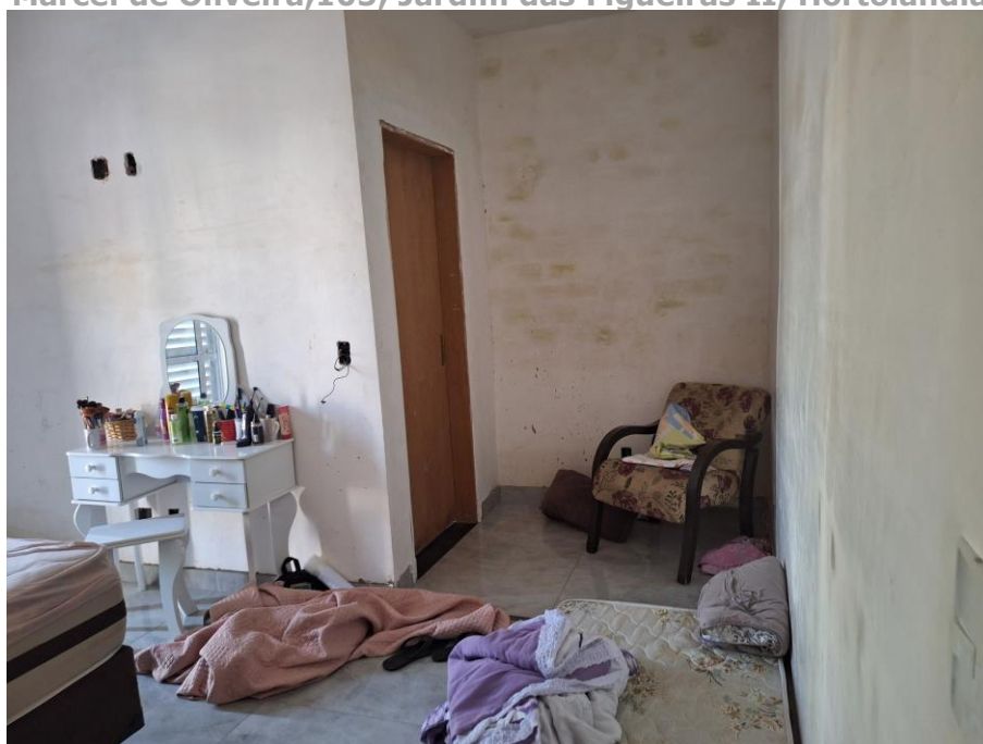
Imagem 95 – Vista Interna – SUÍTE. Paredes em alvenaria / reboco / pintura. Piso cerâmico. Esquadrias em alumínio. Acesso franqueado pelo Executado.
