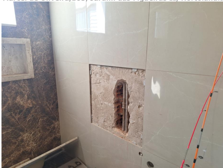
Imagem 89 – Vista Interna – BANHEIRO. Paredes em alvenaria / reboco / revestimento porcelanato. Piso porcelanato. Obra em andamento.
