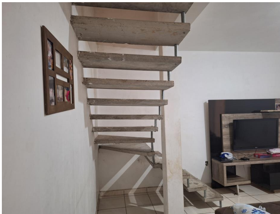
Imagem 60 – Vista Interna – SALA. Paredes em alvenaria / reboco / parte em pintura. Piso cerâmico. Vista para escada de acesso ao piso superior. Escada em concreto e aço. Acesso franqueado pelo Executado.
