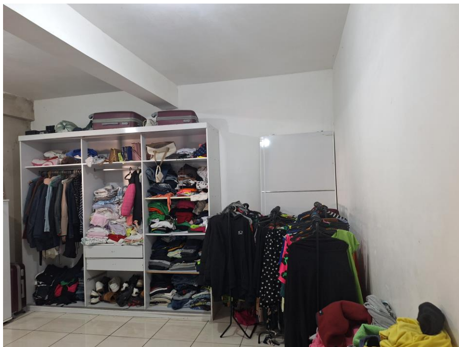
Imagem 54 – Vista Interna – DORMITÓRIO. Paredes em alvenaria / reboco / parte em pintura (obra não finalizada). Piso cerâmico. Esquadrias em ferro e madeira. Acesso franqueado pelo Executado.
