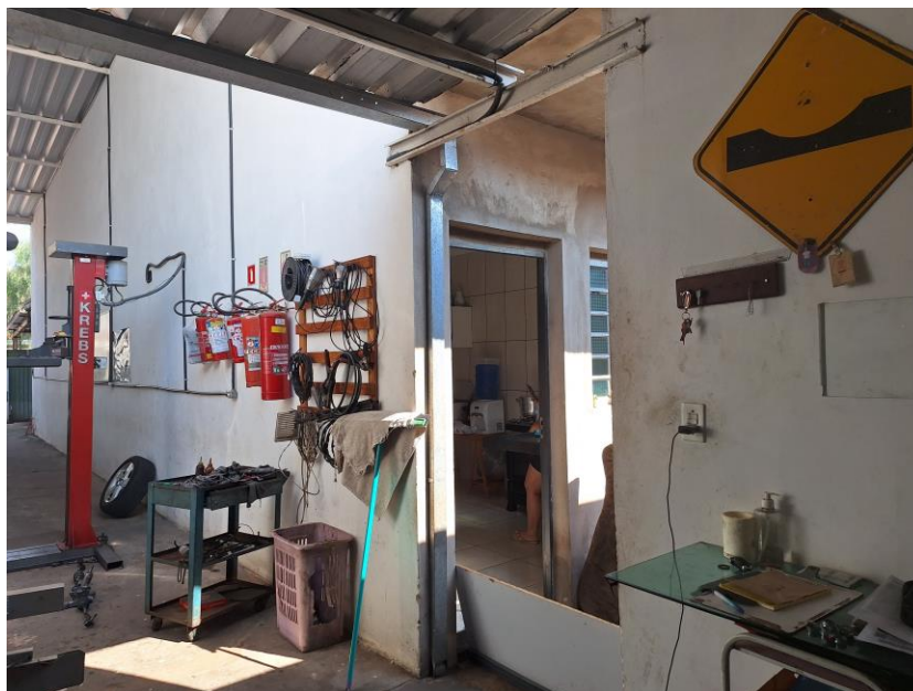
Imagem 34 – Vista Interna – OFICINA MECÂNICA. Depósito de ferramentas da oficina. Vista para a passagem de acesso à residência do imóvel. Parede em alvenaria / reboco / pintura. Piso cimentado. Cobertura metálica.
