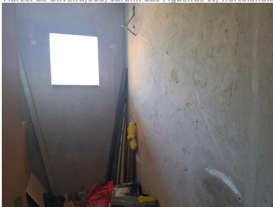
Imagem 101 – Vista Interna – BANHEIRO DA SUÍTE. Paredes em alvenaria / reboco. Piso cimentado (contrapiso). Obra em andamento.
