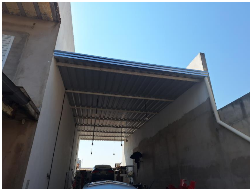
Imagem 20 – Vista Interna – OFICINA MECÂNICA. Paredes em alvenaria / reboco / parte com acabamento em pintura. Piso cimentado. Cobertura em estrutura metálica. Vista para carros em espera e em manutenção.
