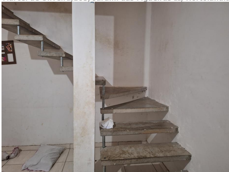
Imagem 61 – Vista Interna – ESCADAS. Paredes em alvenaria / reboco / parte em pintura. Piso cerâmico. Vista para escada de acesso ao piso superior. Escada em concreto e aço. Acesso franqueado pelo Executado.
