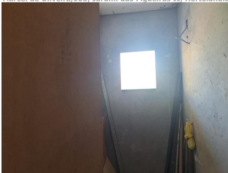
Imagem 103 – Vista Interna – BANHEIRO DA SUÍTE. Paredes em alvenaria / reboco. Piso cimentado (contrapiso). Obra em andamento. Acesso franqueado pelo Executado.
