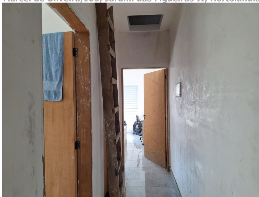
Imagem 65 – Vista Interna – CIRCULAÇÃO. Paredes em alvenaria / reboco / pintura. Piso cerâmico. Esquadrias em madeira. Acesso franqueado pelo Executado.
