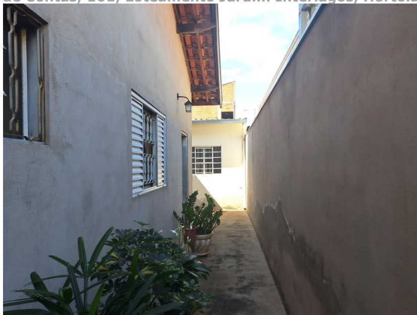
Imagem 63 – Vista Interna – CORREDOR LATERAL. Paredes em alvenaria / reboco. Piso cimentado. Esquadrias em alumínio. Acesso franqueado pelo EXECUTADO.
