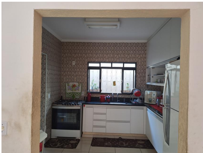
Imagem 28 – Vista Interna – COZINHA. Vista para cozinha da residência. Paredes em alvenaria / reboco / revestimento cerâmico. Piso com revestimento cerâmico. Esquadria em alumínio. Mobiliário em marcenaria. Acesso franqueado pelo EXECUTADO.
