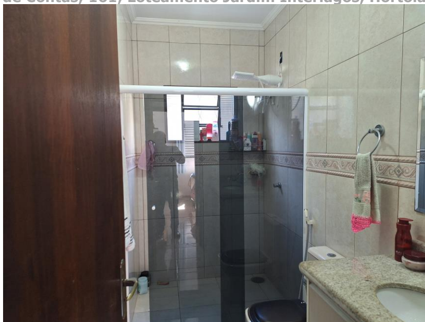
Imagem 45 – Vista Interna – BANHEIRO. Paredes em alvenaria / reboco / revestimento cerâmico. Piso com revestimento cerâmico. Esquadria em madeira e alumínio. Mobiliário em marcenaria. Box em vidro e alumínio.
