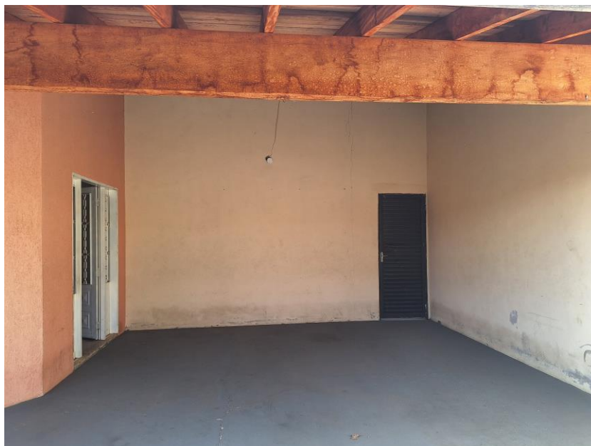
Imagem 14 – Vista Interna – GARAGEM. Vista para garagem da residência. Muros em alvenaria. Paredes em alvenaria / reboco / pintura. Esquadrias em alumínio. Piso cimentado. Cobertura cerâmica com estrutura de madeira.
