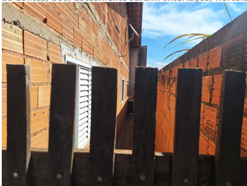
Imagem 69 – Vista Interna – CORREDOR LATERAL. Paredes em alvenaria (sem acabamento). Piso cimentado. Portão de madeira. Acesso franqueado pelo EXECUTADO.
