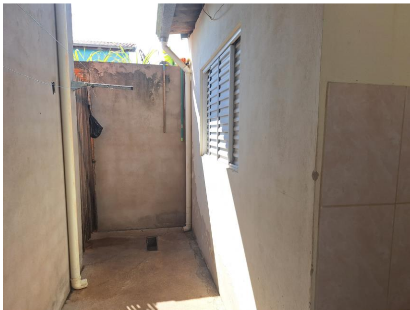
Imagem 82 – Vista Interna – CASA FUNDOS. Paredes em alvenaria / reboco / pintura. Piso cimentado. Esquadrias em ferro e vidro. Cobertura em telha de fibrocimento e estrutura em madeira. Acesso franqueado pelo EXECUTADO.
