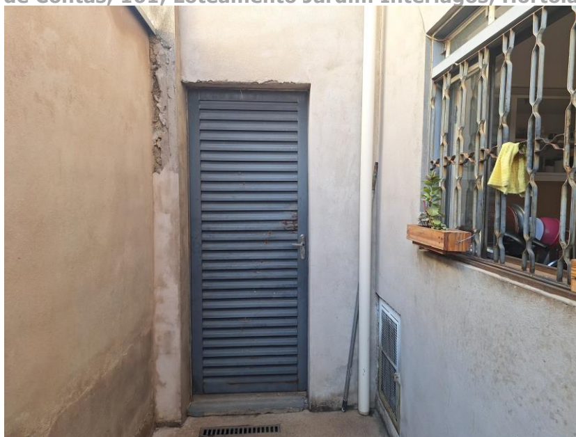
Imagem 61 – Vista Interna – CORREDOR LATERAL. Paredes em alvenaria / reboco. Piso cimentado. Esquadrias em alumínio. Acesso franqueado pelo EXECUTADO.
