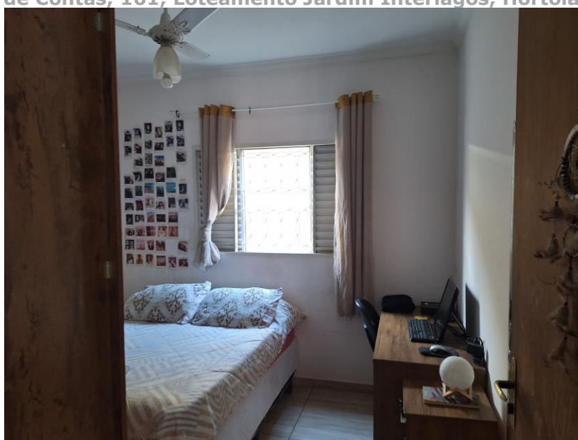
Imagem 53 – Vista Interna – SUÍTE. Paredes em alvenaria / reboco / pintura. Piso com revestimento cerâmico. Esquadria em madeira e alumínio.
