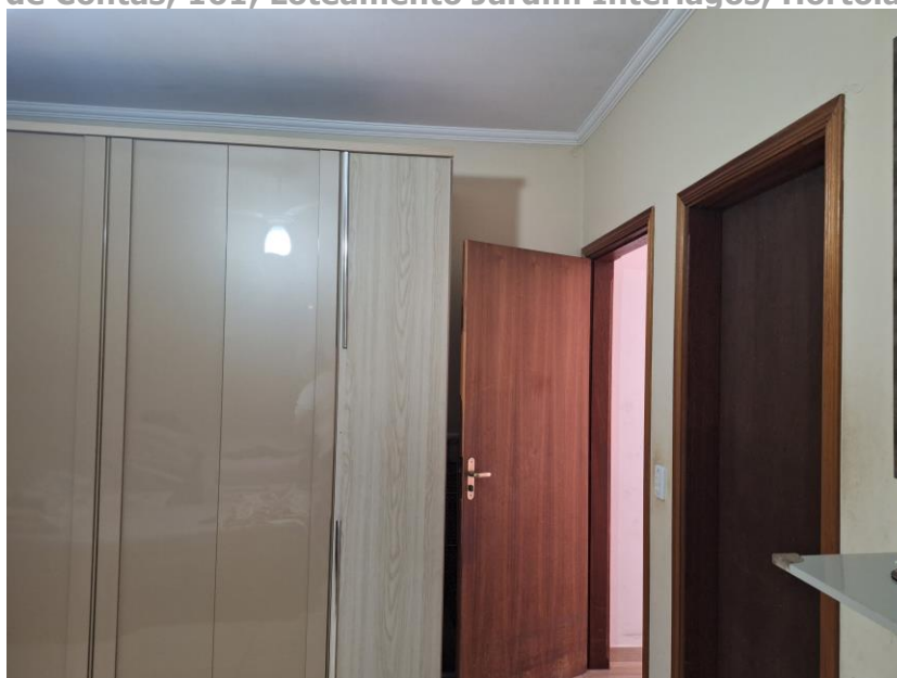
Imagem 51 – Vista Interna – SUÍTE. Paredes em alvenaria / reboco / pintura. Piso com revestimento cerâmico. Esquadria em madeira e alumínio.
