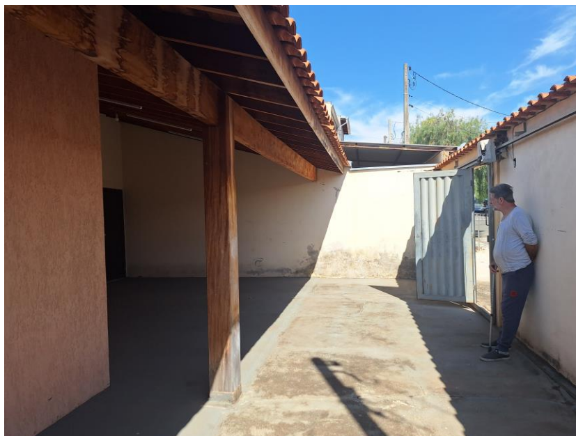
Imagem 16 – Vista Interna – GARAGEM. Vista para garagem da residência. Muros em alvenaria. Paredes em alvenaria / reboco / pintura. Esquadrias em alumínio. Piso cimentado. Cobertura cerâmica com estrutura de madeira.
