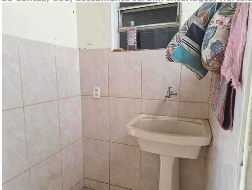
Imagem 83 – Vista Interna – CASA FUNDOS. ÁREA DE SERVIÇO. Paredes em alvenaria / reboco / pintura e revestimento cerâmico. Piso com revestimento cerâmico. Esquadrias em ferro e vidro. Acesso franqueado pelo EXECUTADO.
