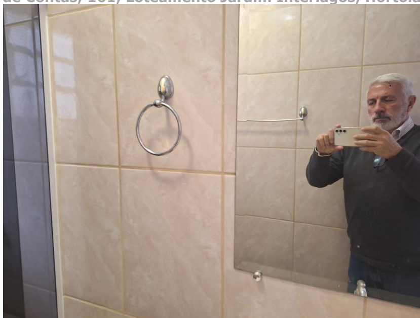
Imagem 77 – Vista Interna – CASA FUNDOS. BANHEIRO. Paredes em alvenaria / reboco / revestimento cerâmico. Piso com revestimento cerâmico. Forro de PVC.
