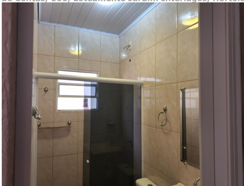
Imagem 75 – Vista Interna – CASA FUNDOS. BANHEIRO. Paredes em alvenaria / reboco / revestimento cerâmico. Piso com revestimento cerâmico. Forro de PVC.
