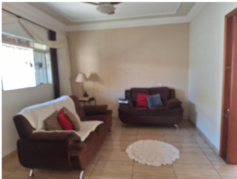
Imagem 20 – Vista Interna – SALA ESTAR. Vista para sala de estar da residência. Paredes em alvenaria / reboco / pintura. Piso com revestimento cerâmico. Esquadria em madeira. Acesso franqueado pelo EXECUTADO.
