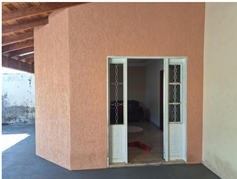
Imagem 18 – Vista Interna – GARAGEM. Vista para garagem da residência. Muros em alvenaria. Paredes em alvenaria / reboco / pintura. Esquadrias em alumínio. Piso cimentado. Cobertura cerâmica com estrutura de madeira.
