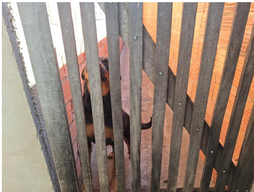
Imagem 68 – Vista Interna – CORREDOR LATERAL. Paredes em alvenaria (sem acabamento). Piso cimentado. Portão de madeira. Acesso franqueado pelo EXECUTADO.
