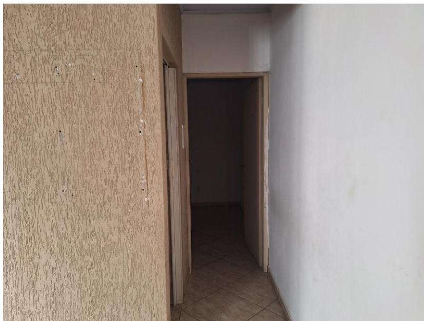
Imagem 74 – Vista Interna – CASA FUNDOS. CIRCULAÇÃO. Paredes em alvenaria / reboco / pintura. Piso com revestimento cerâmico. Forro de PVC.
