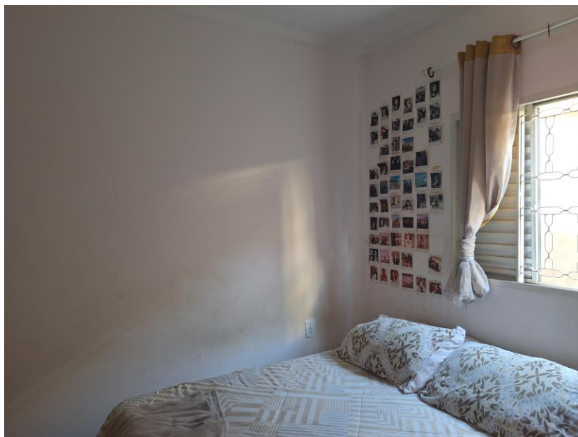
Imagem 48 – Vista Interna – DORMITÓRIO. Paredes em alvenaria / reboco / pintura. Piso com revestimento cerâmico. Esquadria em madeira e alumínio.
