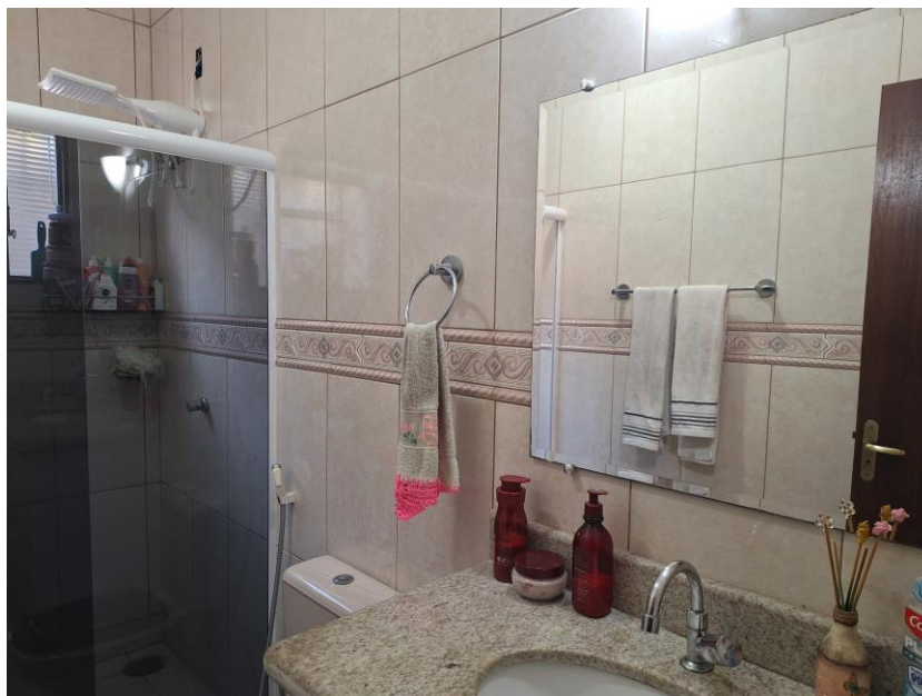
Imagem 44 – Vista Interna – BANHEIRO. Paredes em alvenaria / reboco / revestimento cerâmico. Piso com revestimento cerâmico. Esquadria em madeira e alumínio. Mobiliário em marcenaria. Box em vidro e alumínio.
