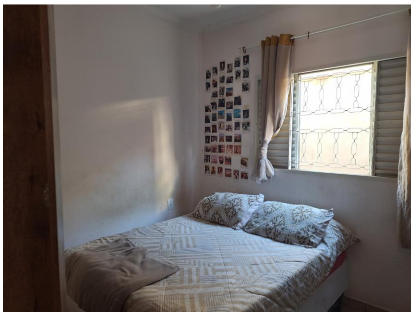
Imagem 54 – Vista Interna – SUÍTE. Paredes em alvenaria / reboco / pintura. Piso com revestimento cerâmico. Esquadria em madeira e alumínio.
