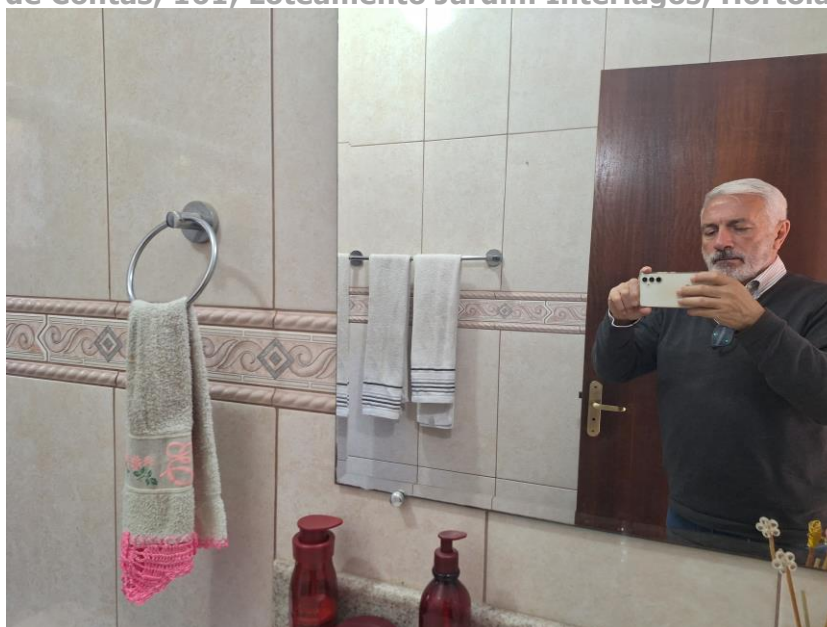
Imagem 47 – Vista Interna – BANHEIRO. Paredes em alvenaria / reboco / revestimento cerâmico. Piso com revestimento cerâmico. Esquadria em madeira e alumínio. Mobiliário em marcenaria. Box em vidro e alumínio.
