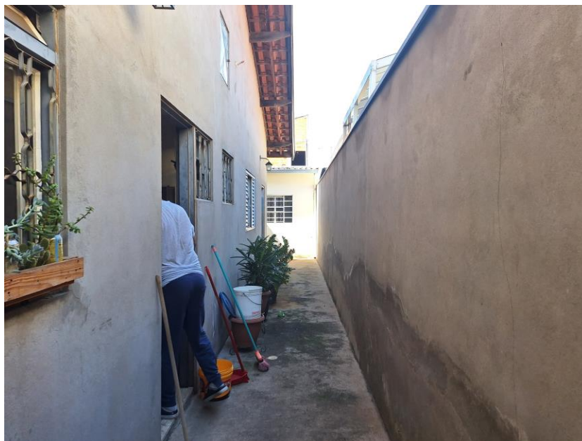
Imagem 62 – Vista Interna – CORREDOR LATERAL. Paredes em alvenaria / reboco. Piso cimentado. Esquadrias em alumínio. Acesso franqueado pelo EXECUTADO.
