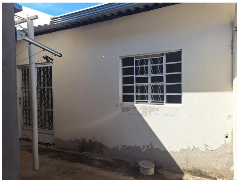
Imagem 70 – Vista Interna – CASA FUNDOS. Paredes em alvenaria / reboco / pintura. Piso cimentado. Porta de ferro e vidro. Cobertura em telha de fibrocimento e estrutura em madeira. Acesso franqueado pelo EXECUTADO.
