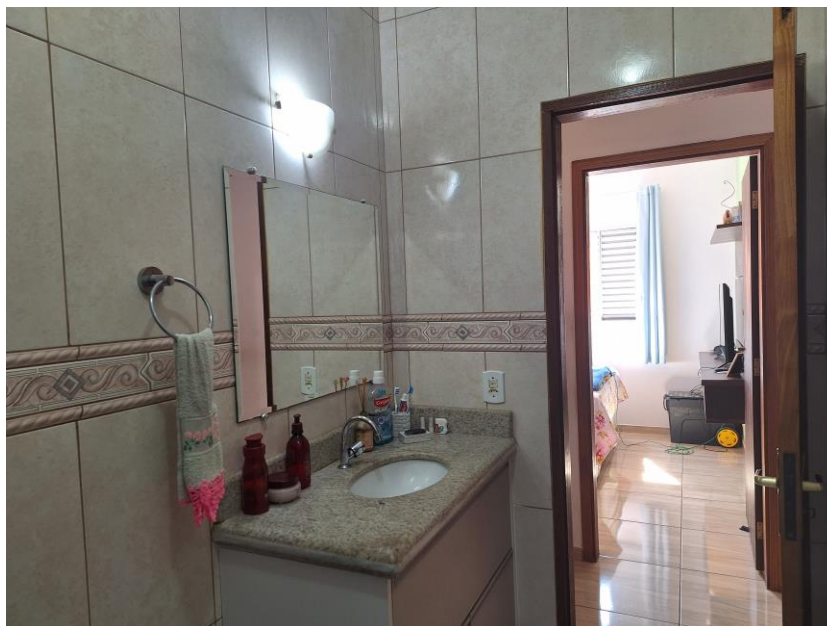
Imagem 46 – Vista Interna – BANHEIRO. Paredes em alvenaria / reboco / revestimento cerâmico. Piso com revestimento cerâmico. Esquadria em madeira e alumínio. Mobiliário em marcenaria. Box em vidro e alumínio.
