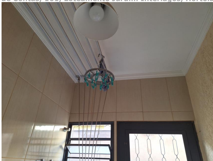
Imagem 33 – Vista Interna – ÁREA DE SERVIÇO. Vista da cozinha para a área de serviço da residência. Paredes em alvenaria / reboco / revestimento cerâmico. Piso com revestimento cerâmico. Esquadria em alumínio. Acesso franqueado pelo EXECUTADO.
