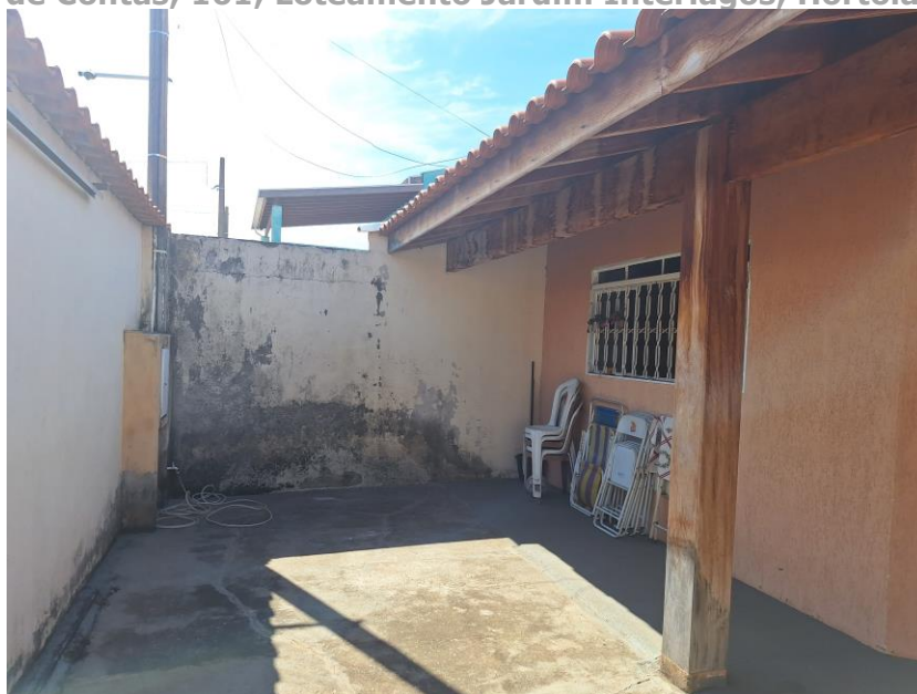
Imagem 15 – Vista Interna – GARAGEM. Vista para garagem da residência. Muros em alvenaria. Paredes em alvenaria / reboco / pintura. Esquadrias em alumínio. Piso cimentado. Cobertura cerâmica com estrutura de madeira.
