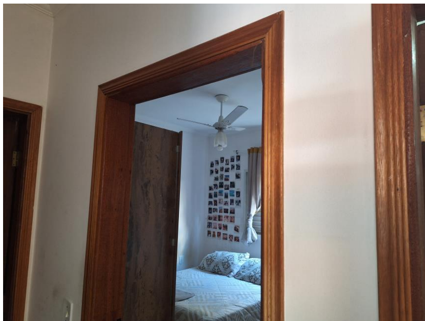
Imagem 52 – Vista Interna – SUÍTE. Paredes em alvenaria / reboco / pintura. Piso com revestimento cerâmico. Esquadria em madeira e alumínio.
