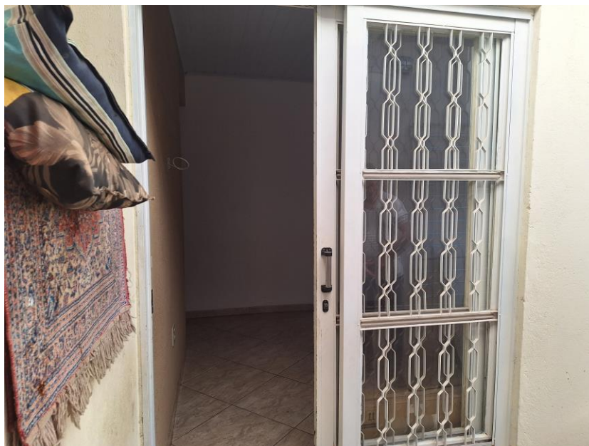
Imagem 72 – Vista Interna – CASA FUNDOS. Paredes em alvenaria / reboco / pintura. Piso cimentado. Porta de ferro e vidro. Cobertura em telha de fibrocimento e estrutura em madeira. Acesso franqueado pelo EXECUTADO.
