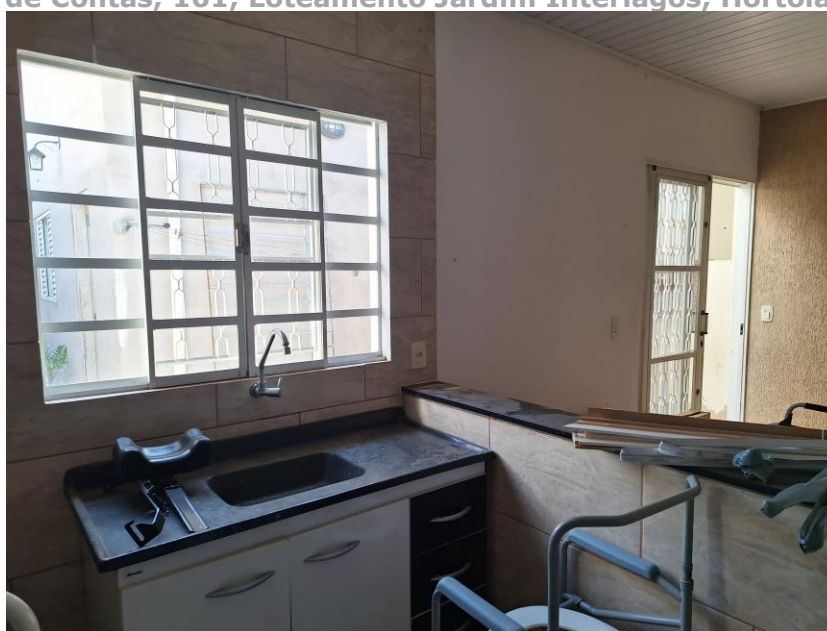
Imagem 73 – Vista Interna – CASA FUNDOS. COZINHA e SALA. Paredes em alvenaria / reboco / revestimento cerâmico e/ou pintura. Piso com revestimento cerâmico. Forro de PVC. Acesso franqueado pelo EXECUTADO.
