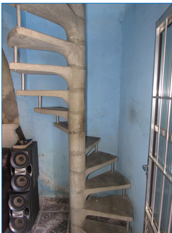
ESCALA DE ACESSO AO PAVIMENTO SUPERIOR.
