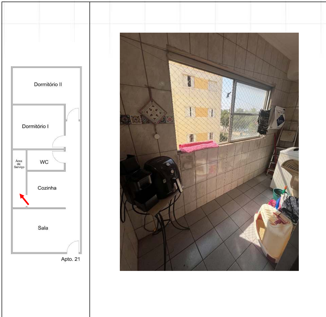
VISTA DA ÁREA DE SERVIÇO.
