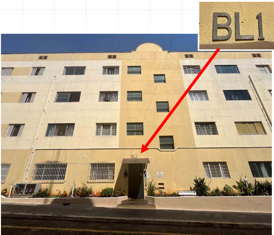
VISTA GERAL DO BLOCO 1 , NO QUAL SE INSERE A UNIDADE AVALIANDA ( APARTAMENTO 21 – 2º PAVIMENTO ).
