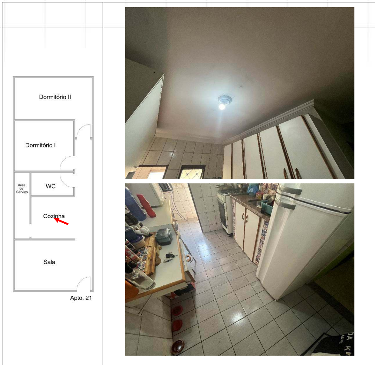
DETALHES DOS ACABAMENTOS DO TETO, PAREDES E PISO DA COZINHA.
