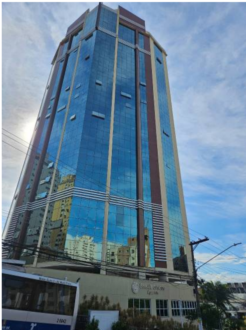
FOTO 3: FACHADA DO EDIFÍCIO PARA A AVENIDA ÁGUA FRIA.
