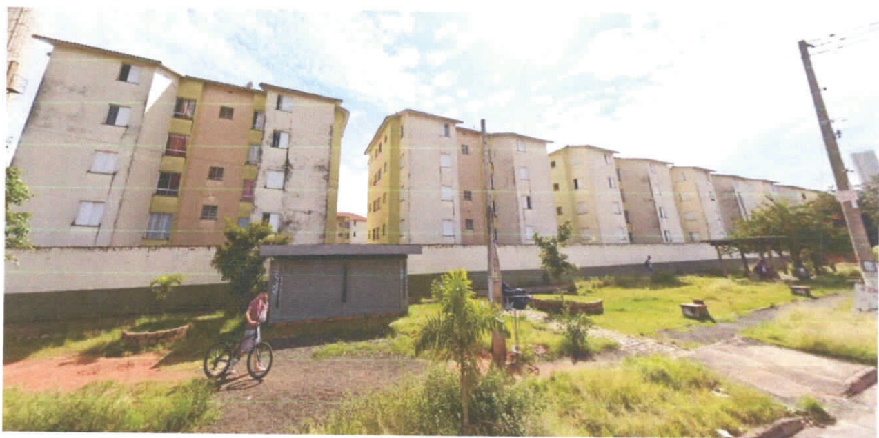
FOTO EXTERNA DO CONDOMINIO
