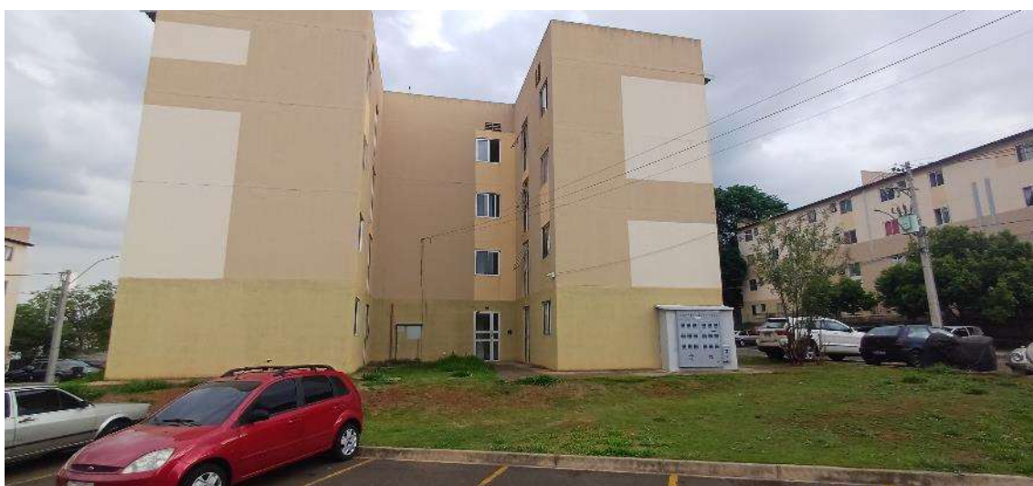
Condomínio Paineiras – Acesso aos edifícios e estacionamento.
