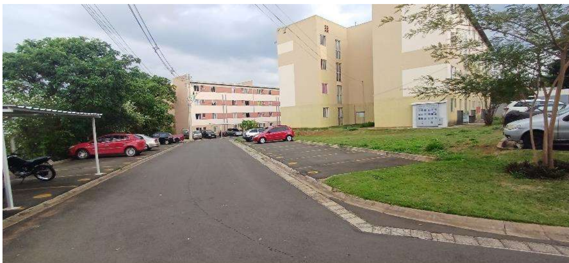
Condomínio Paineiras – Acesso aos edifícios e estacionamento.
