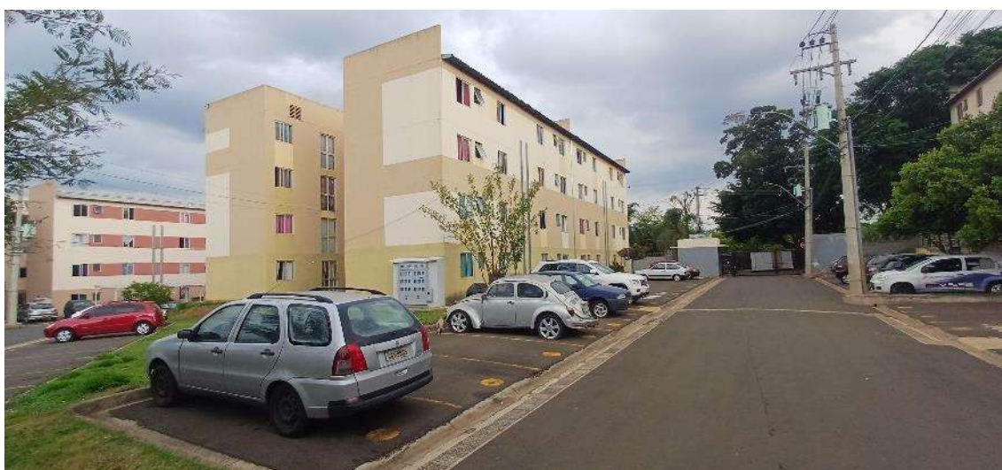
Condomínio Paineiras – Acesso aos edifícios e estacionamento.
