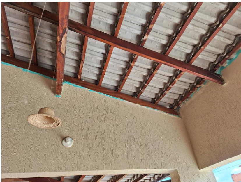
Imagem XX – Vista Interna – Garagem. Paredes em alvenaria / reboco / pintura (parte em revestimento cerâmico). Portão metálico. Piso cerâmico. Vista para a cobertura. Cobertura em telha cimentícia com estrutura em madeira. Acesso franqueado pelo Executado.
