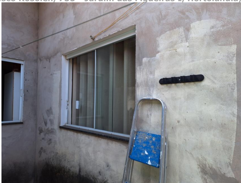
Imagem XX – Vista Interna – Área livre. Piso cimentado. Parede em alvenaria / reboco (obra não finalizada). Acesso franqueado pelo Executado.
