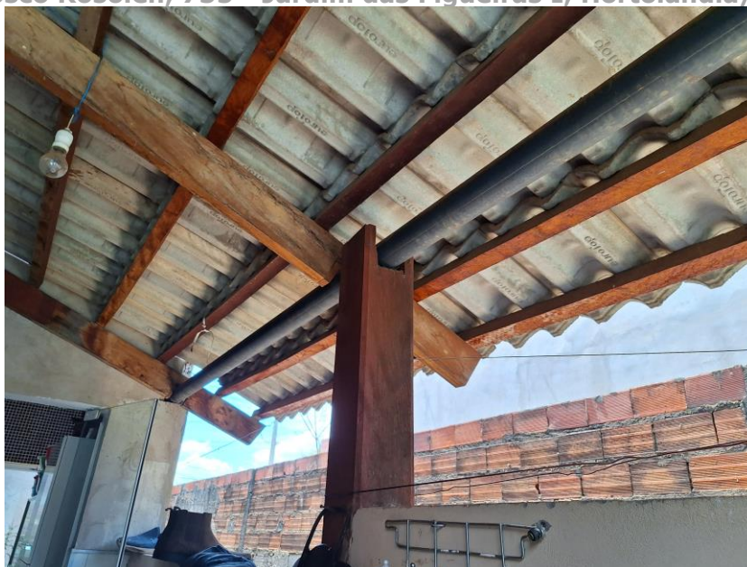
Imagem XX – Vista Interna – Área de lazer. Vista para cobertura.
