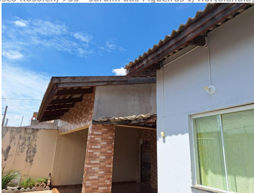
Imagem XX – Vista Interna – Garagem. Paredes em alvenaria / reboco / pintura (parte em revestimento cerâmico). Portão metálico. Piso cerâmico. Acesso franqueado pelo Executado.
