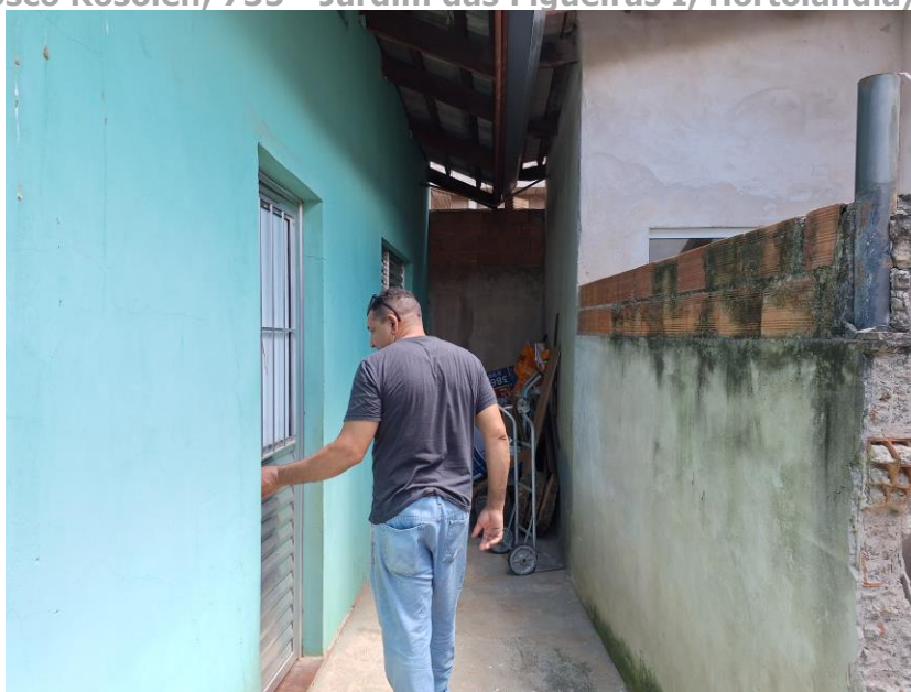
Imagem XX – Vista Interna – Acesso à área dos fundos da residência. Piso cimentado. Parede em alvenaria / reboco / pintura. Esquadrias em alumínio. Acesso franqueado pelo Executado.
