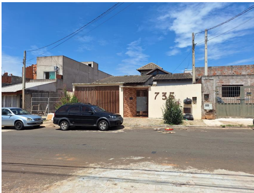
Imagem XX – Vista Externa – Fachada Principal. Visão pela rua frontal. Muro em alvenaria / reboco / pintura. Portão metálico. Acesso franqueado pelo Executado.
