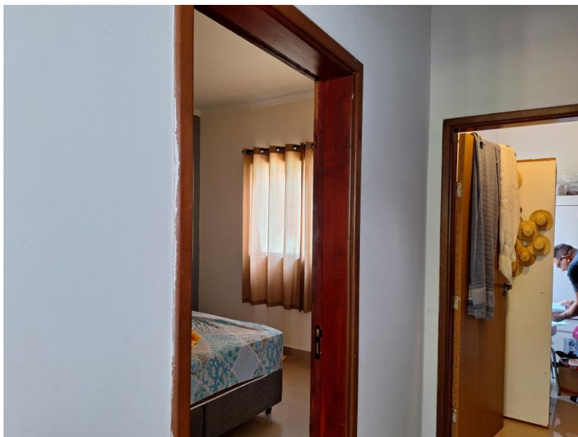
Imagem XX – Vista Interna – Sala. Vista para acesso aos dormitórios da residência. Esquadria em alumínio e vidro / madeira. Piso porcelanato. Parede em alvenaria / reboco / pintura Acesso franqueado pelo Executado.
