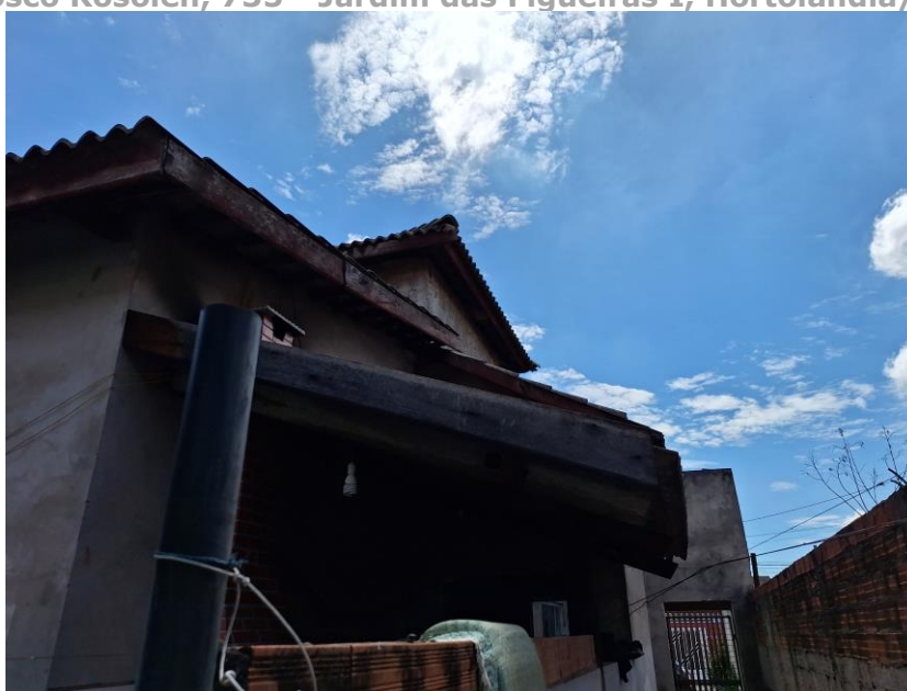
Imagem XX – Vista Interna – Corredor lateral da residência. Piso cimentado. Parede em alvenaria / reboco (obra não finalizada). Acesso franqueado pelo Executado.
