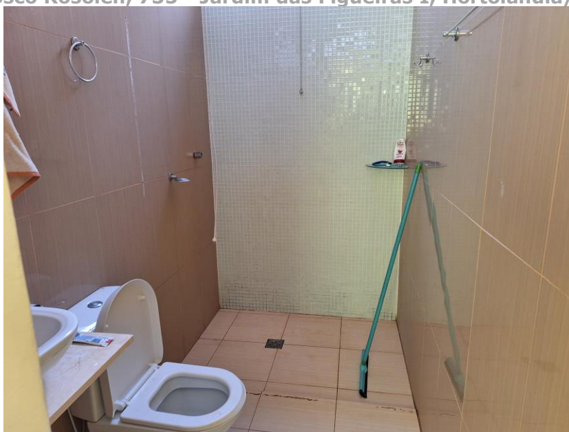
Imagem XX – Vista Interna – Banheiro da Suíte. Paredes em alvenaria / reboco / revestimento cerâmico. Esquadria em alumínio e vidro. Piso cerâmico. Acesso franqueado pelo Executado.
