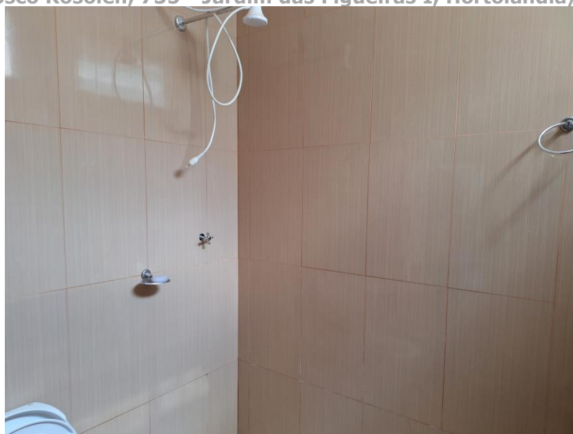
Imagem XX – Vista Interna – Banheiro. Esquadria em alumínio e vidro / madeira. Piso porcelanato. Parede em alvenaria / reboco / revestimento cerâmico. Acesso franqueado pelo Executado.
