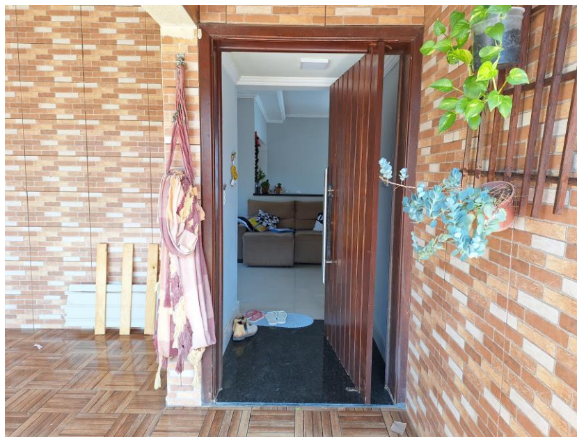
Imagem XX – Vista Interna – Garagem. Vista para porta de acesso principal à residência. Paredes em alvenaria / reboco / revestimento cerâmico. Esquadria em madeira. Piso cerâmico. Acesso franqueado pelo Executado.
