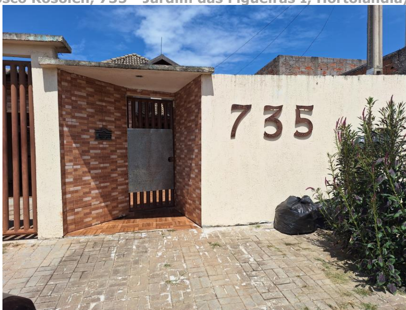
Imagem XX – Vista Externa – Fachada Principal. Visão pela rua frontal. Muro em alvenaria / reboco / pintura. Portão metálico. Acesso franqueado pelo Executado.
