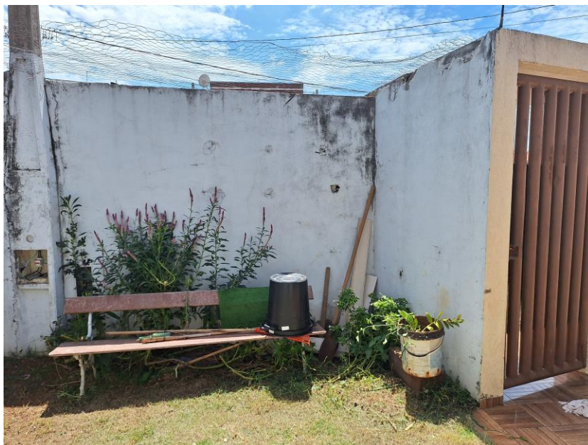
Imagem XX – Vista Interna – Vista de dentro da residência. Garagem. Muro em alvenaria / reboco / pintura. Portão metálico. Acesso franqueado pelo Executado.
