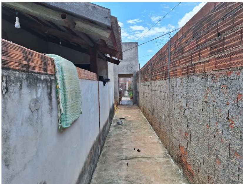
Imagem XX – Vista Interna – Corredor lateral da residência. Piso cimentado. Parede em alvenaria / reboco (obra não finalizada). Acesso franqueado pelo Executado.
