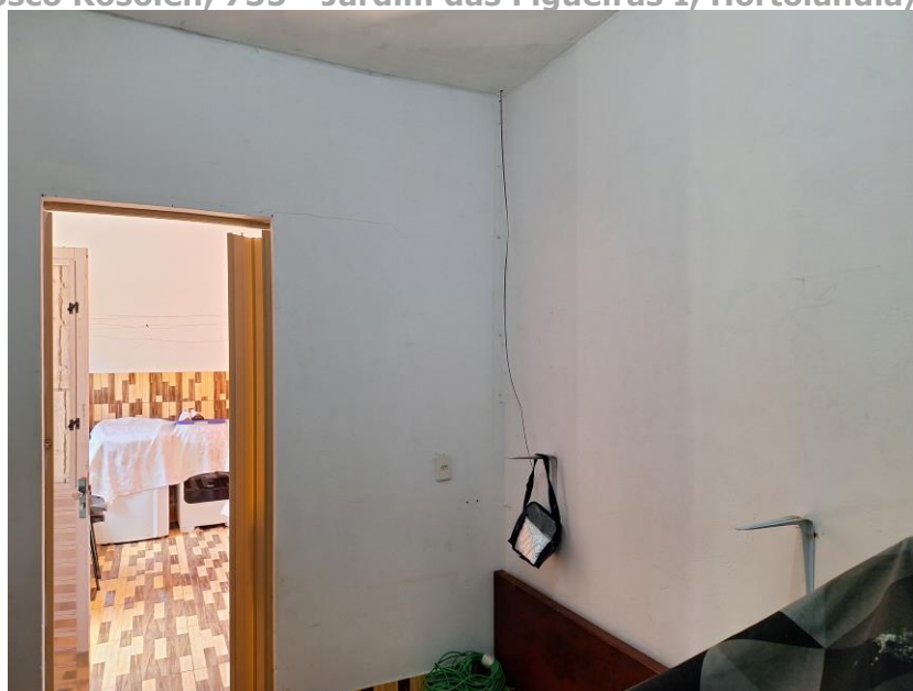
Imagem XX – Vista Interna – Dormitório. Piso cerâmico. Parede em alvenaria / reboco / pintura. Esquadrias em alumínio. Acesso franqueado pelo Executado.
