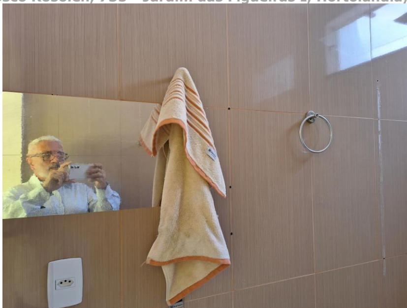
Imagem XX – Vista Interna – Banheiro da Suíte. Paredes em alvenaria / reboco / revestimento cerâmico. Esquadria em alumínio e vidro. Piso cerâmico.
