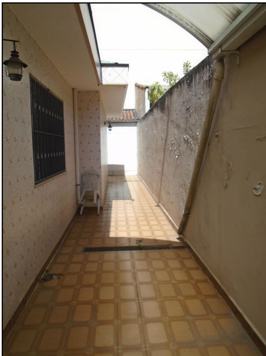
FOTO 24 – RECUO LATERAL E FUNDOS EDIFICAÇÃO.
