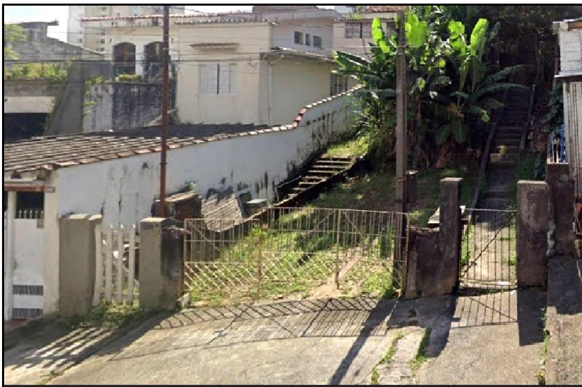
ELEMENTO N. 19 RUA TUCUNA 1260
