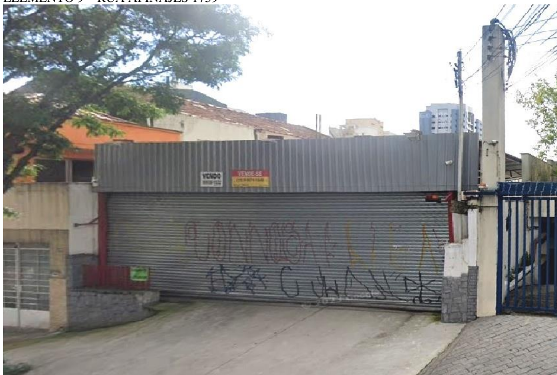
ELEMENTO 10 - RUA BARAO DO BANANAL 1666
