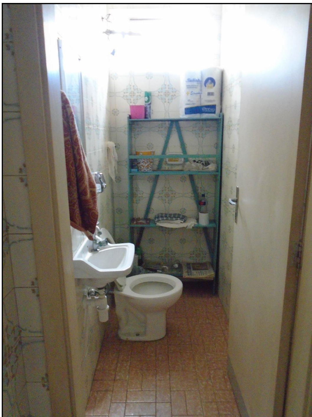
FOTO 07 – ASPECTO DO W.C..
