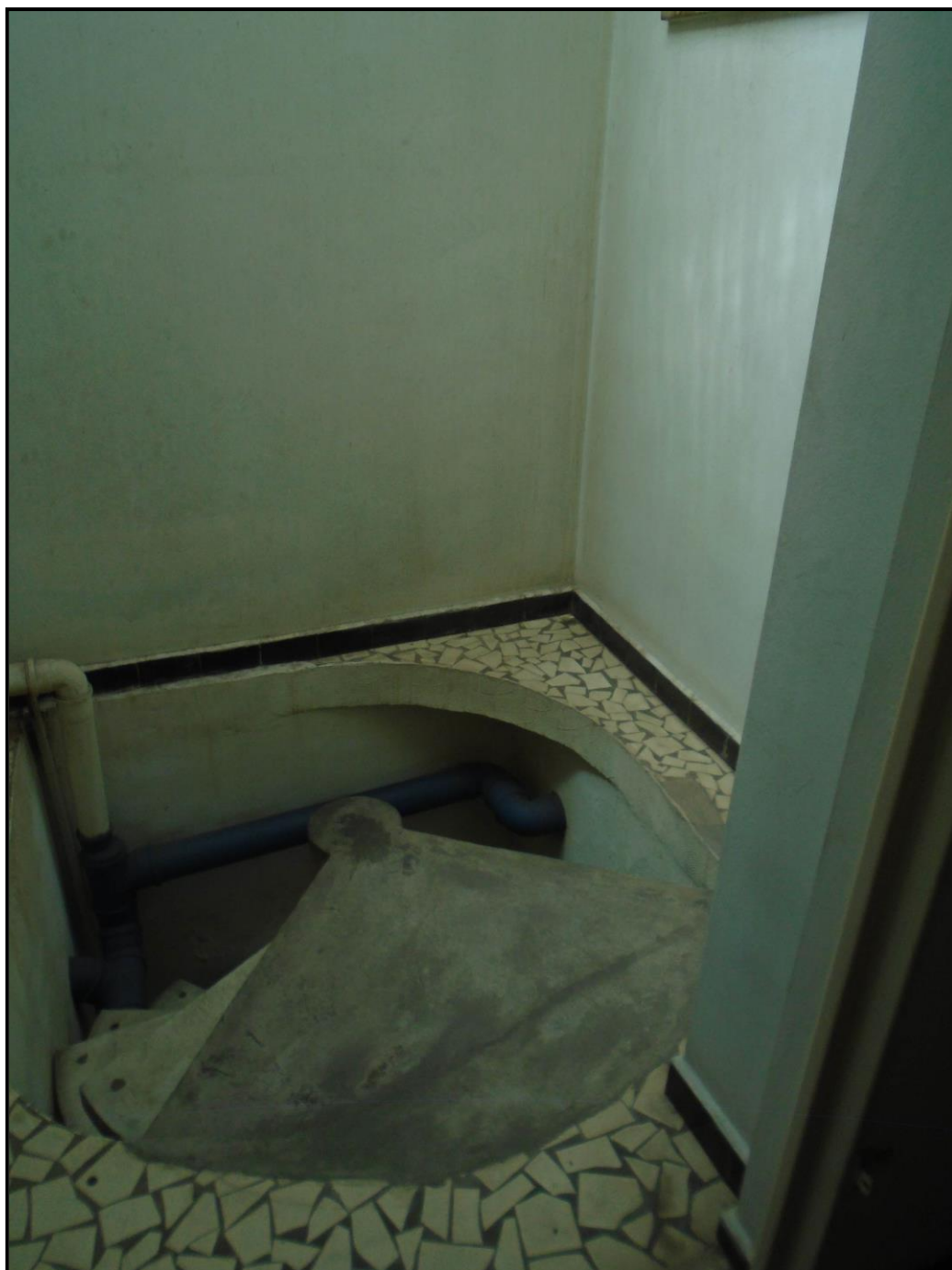
FOTO 18 – DETALHE DA ESCADA CARACOL.
