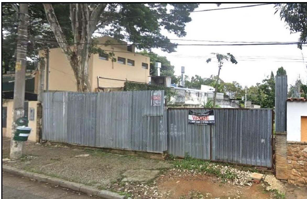
ELEMENTO N. 18 – RUA TREMEMBE 51
