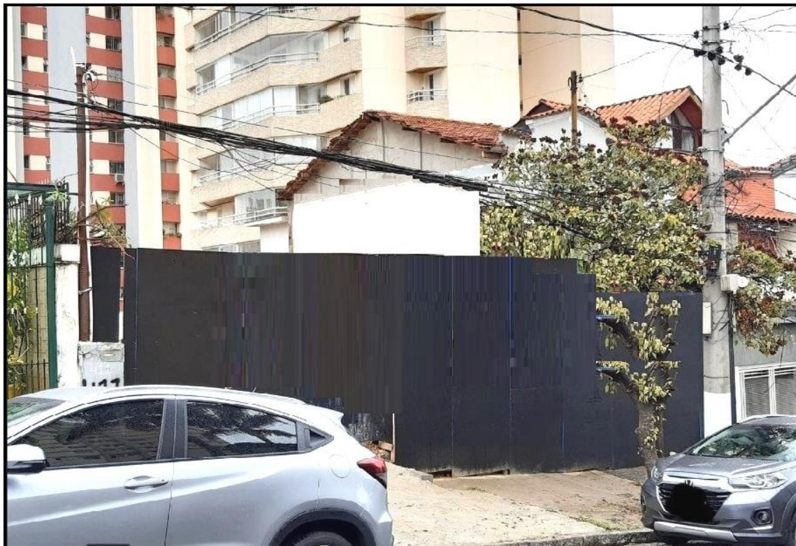
ELEMENTO N. 16 RUA GUIARA 405
