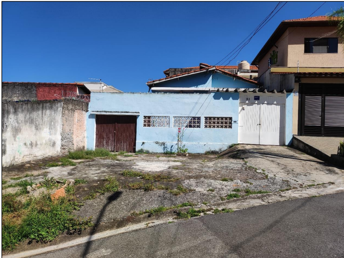
Figura 2 – Vista da fachada do Avaliando.
