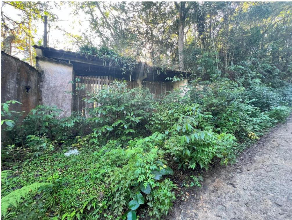
VISTA DA FACHADA DO IMÓVEL PRÓXIMO AO TERRENO AVALIANDO.
