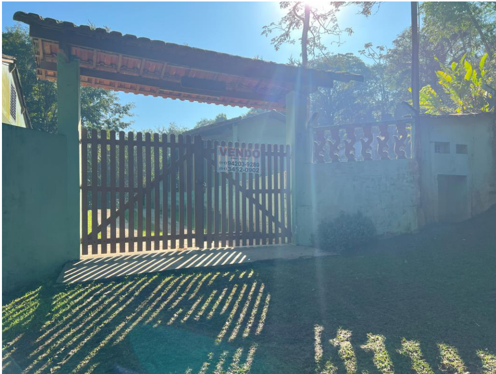
VISTA DA FACHADA DA RESIDÊNCIA Nº 07, CONFRONTANTE DA FRENTE DO IMÓVEL AVALIANDO.
