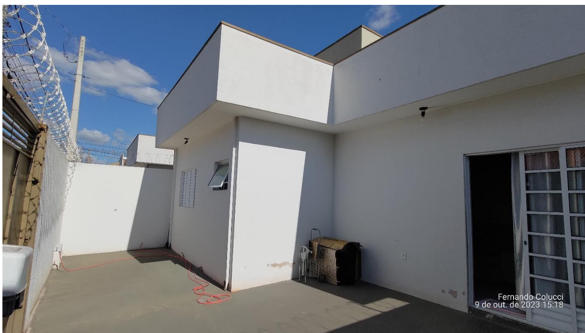
Figura 21 - Garagem do imóvel – vista 2
