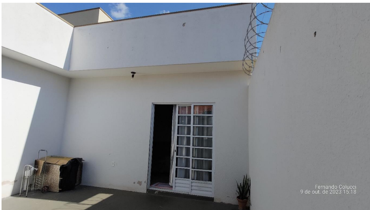
Figura 20 - Garagem do imóvel – vista 1
