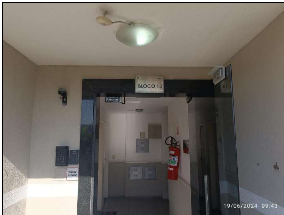
Vista da entrada do Bloco 13.
