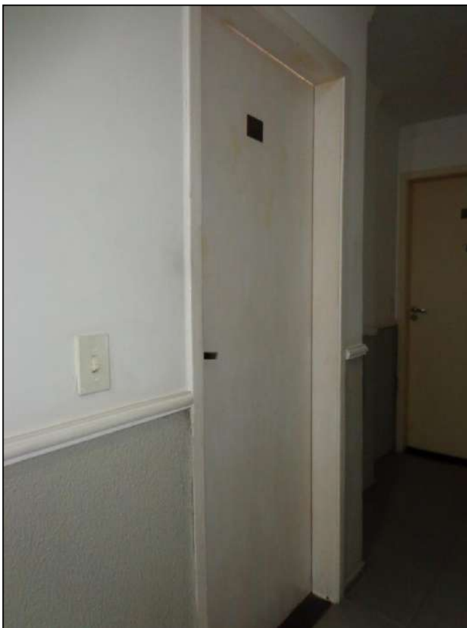
Vista da porta de entrada da unidade n° 505.
