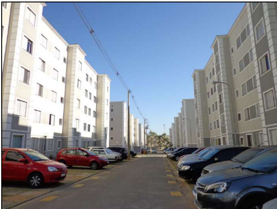
Vista da área de estacionamento do Condomínio.
