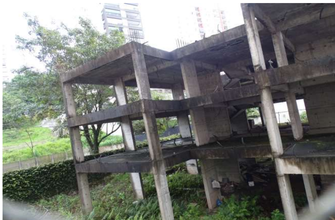
FOTOS -31 e 32 - BLOCO - B - CONSTRUÇÃO INACABADA
