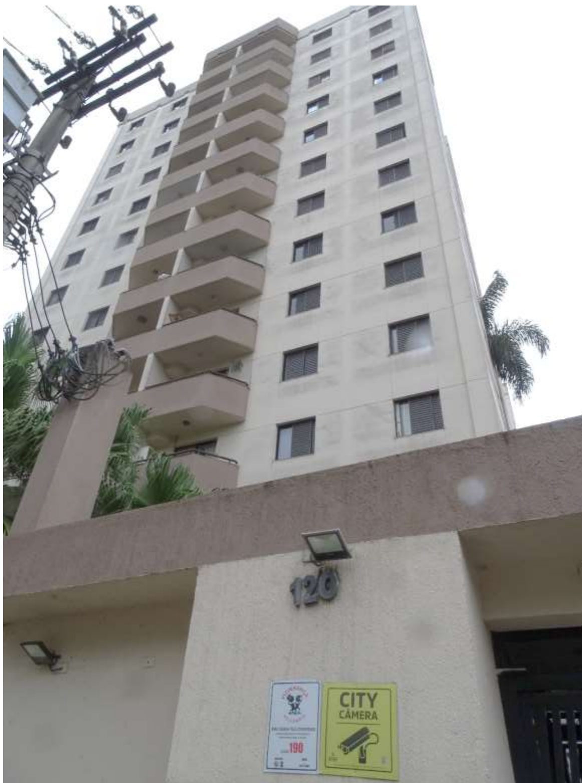
FOTO -51 - VISTA EXTERNA
