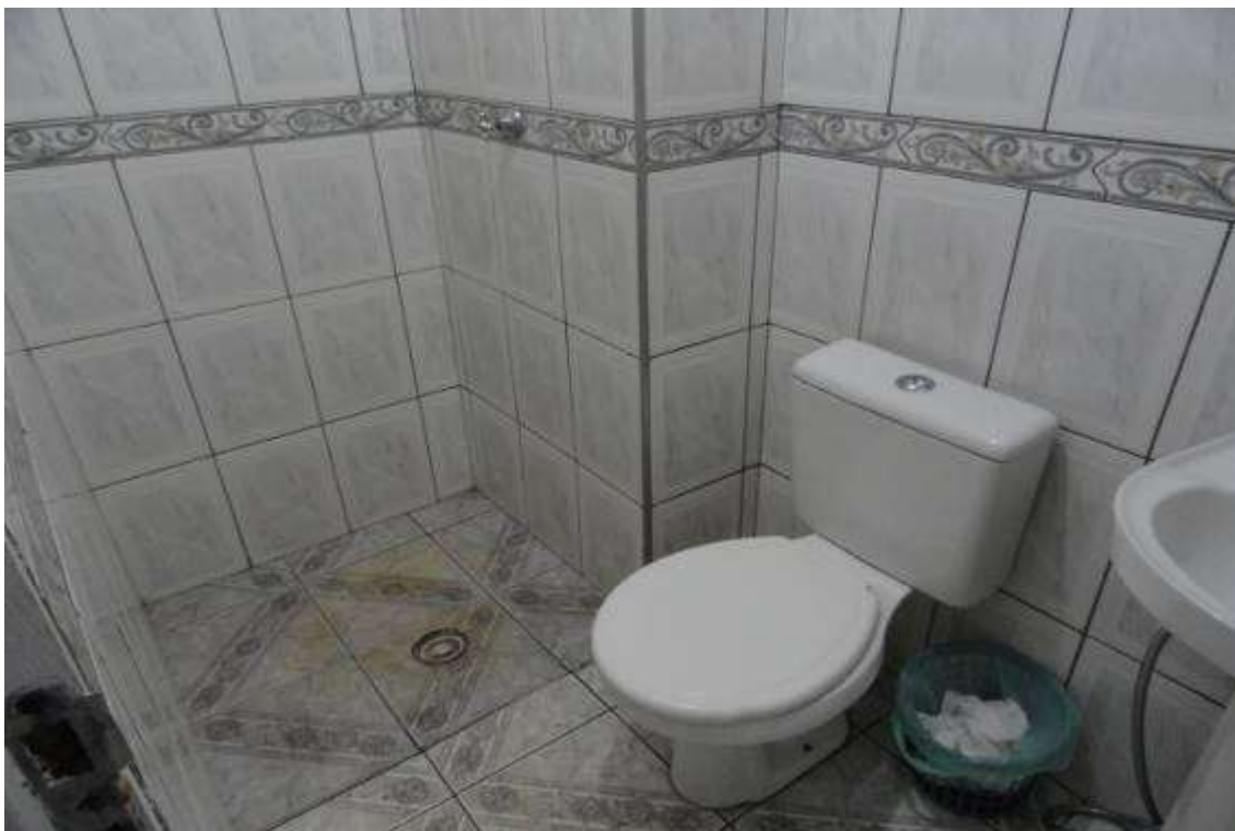
FOTO Nº 14 – Vista do banheiro.
