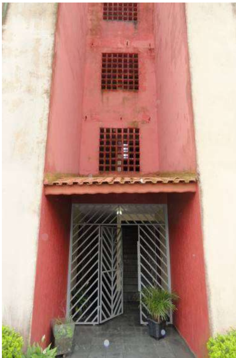
FOTO Nº 05 – Vista do bloco 01, de acesso ao apartamento de nº 23, localizado no 2º andar.
