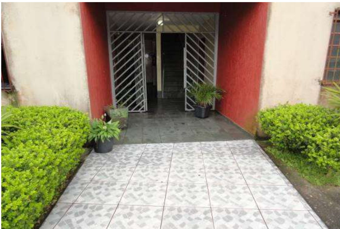
FOTO Nº 06 – Vista da porta de acesso do bloco 01.
