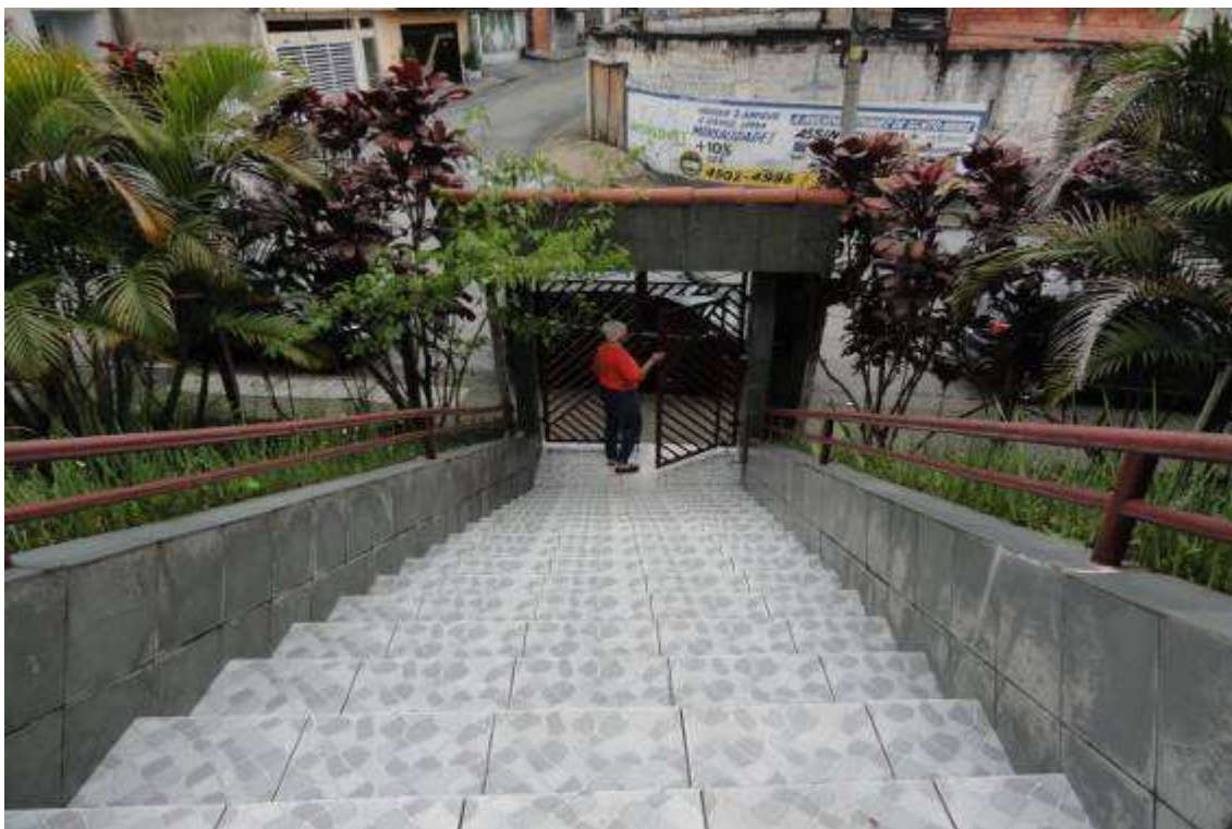
FOTO Nº 04 – Vista do portão de acesso ao prédio.
