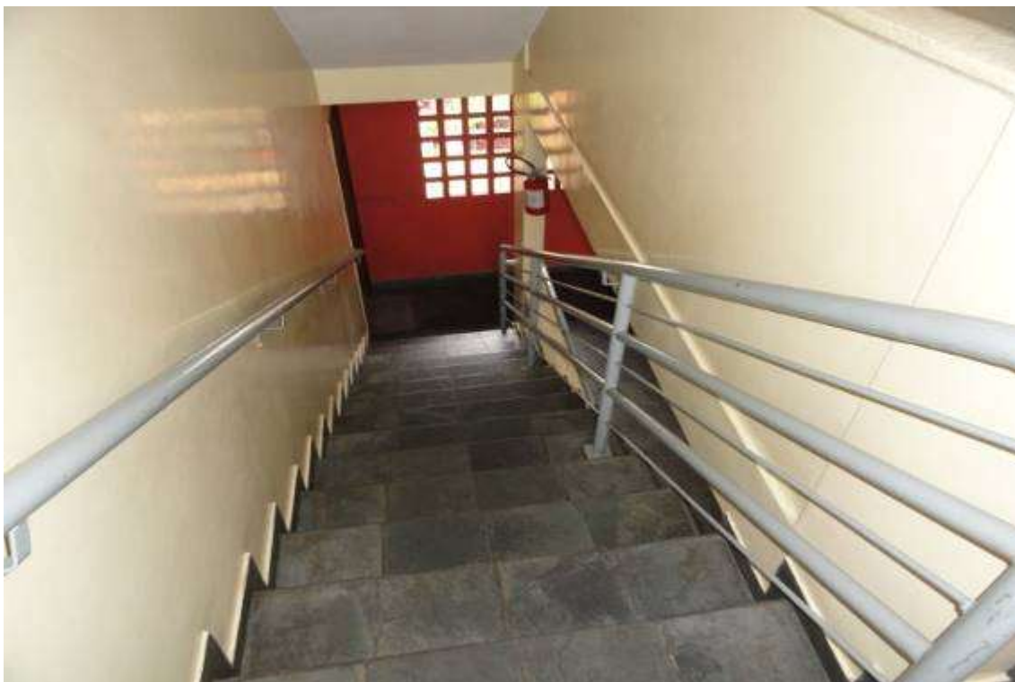
FOTO Nº 08 – Vista da escada de acesso ao 2º andar, onde se localiza o apartamento de nº 23.
