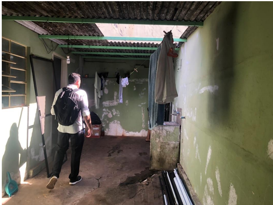
VISTA DO CORREDOR.
