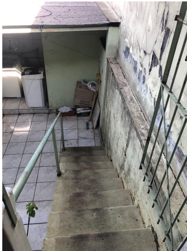
VISTA DA ESCADA DE ACESSO AO PAVIMENTO INFERIOR.
