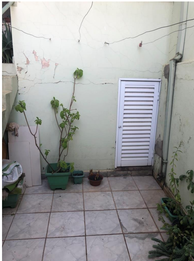
VISTA DA ÁREA EXTERNA.
