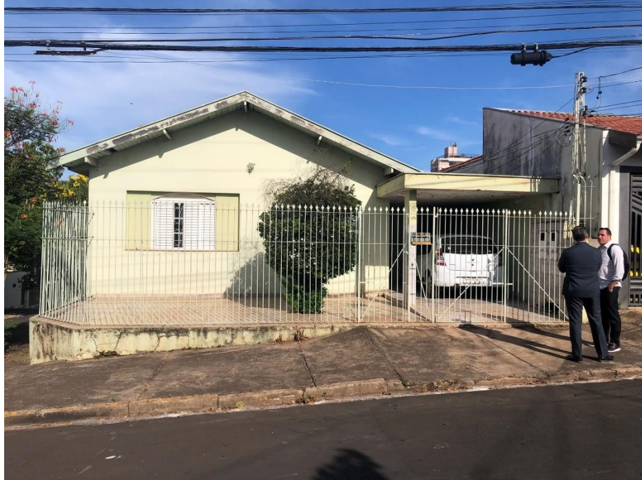
VISTA DA FACHADA DO IMÓVEL – CASA 01.
