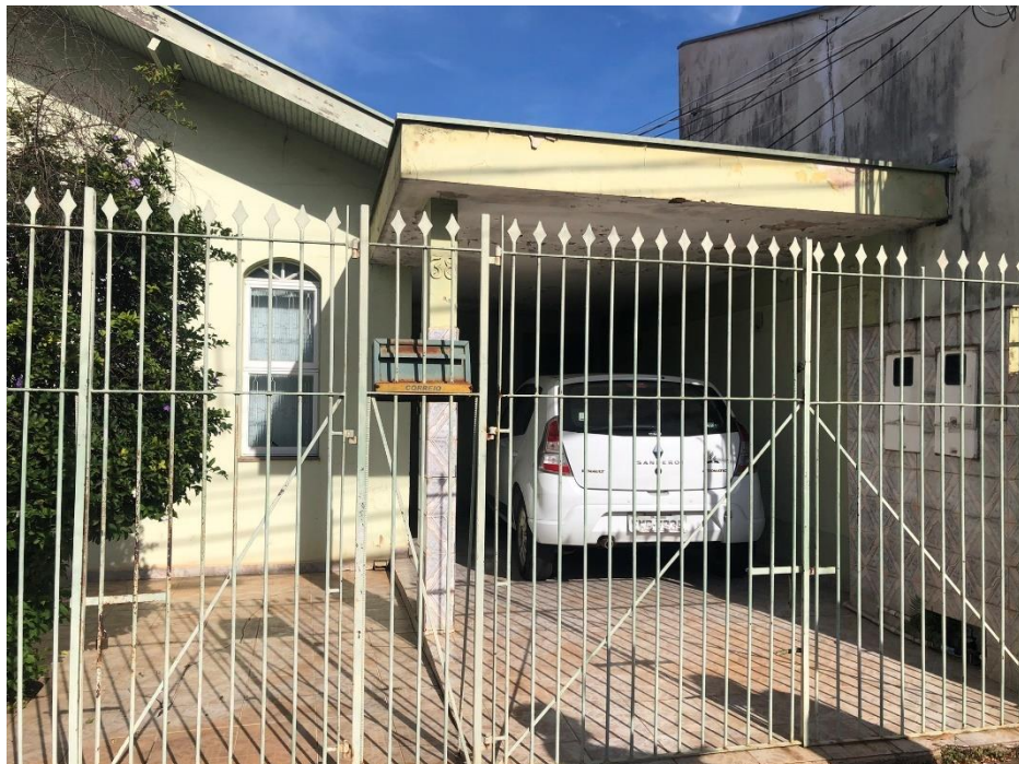
VISTA DA ENTRADA DO IMÓVEL.
