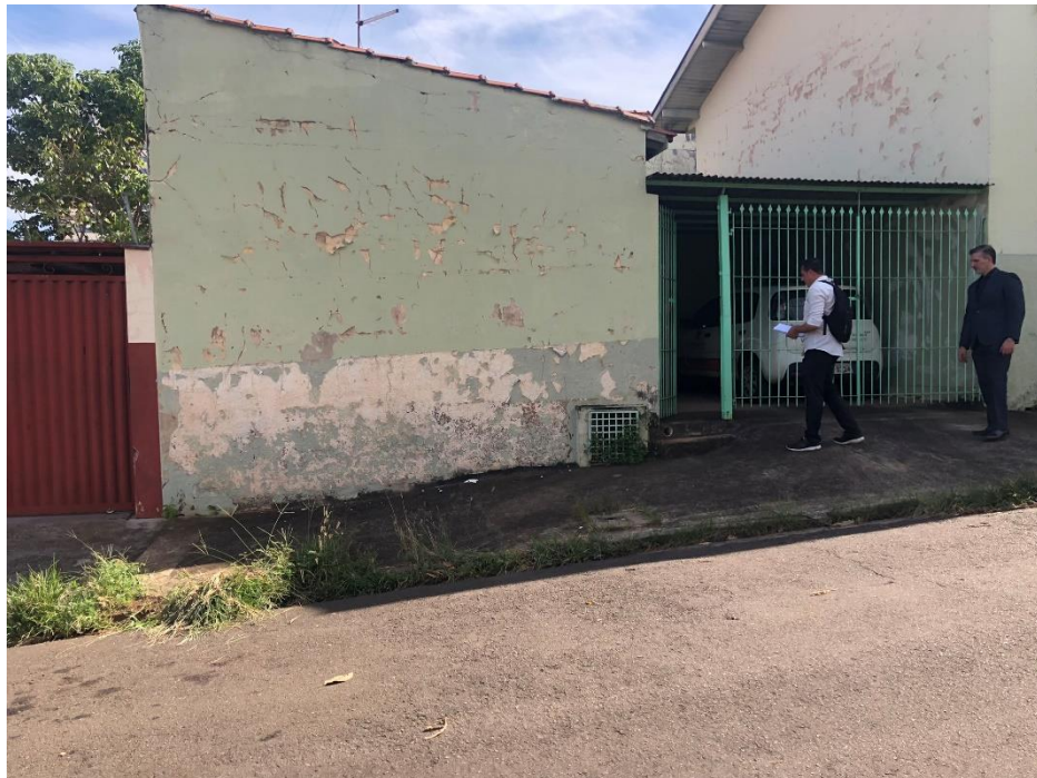
VISTA DA ENTRADA DA CASA 2.
