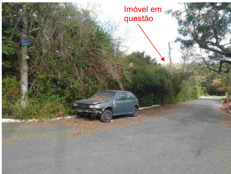
Vista parcial da Rua Acatlan, antiga Rua Sigma, no trecho onde fica o imóvel, objeto da presente demanda.
