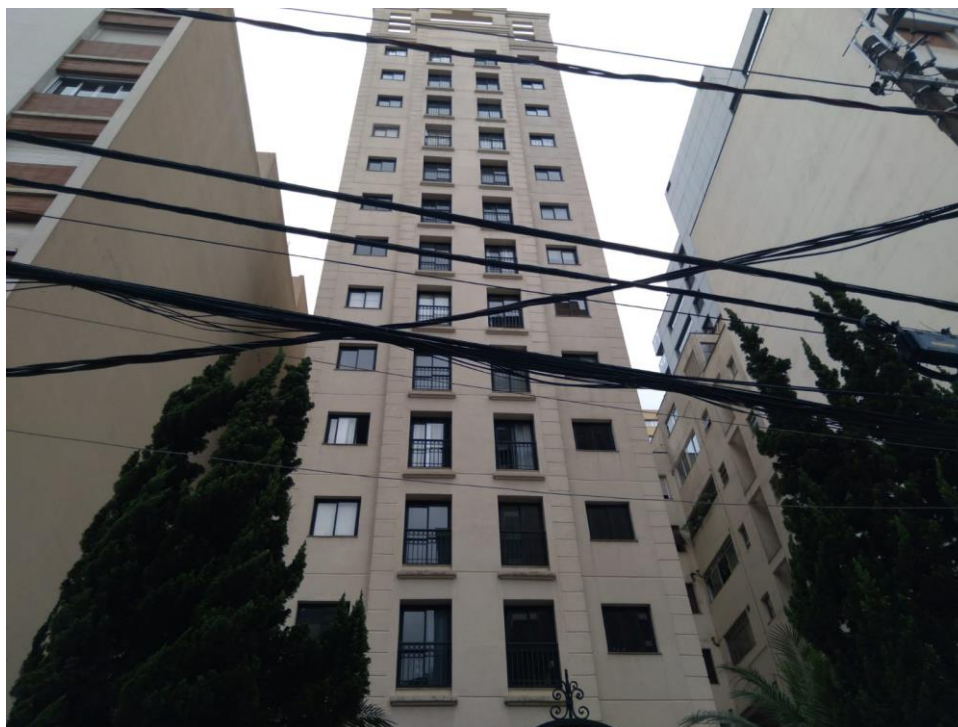
Imagem 1: Fachada do prédio.
