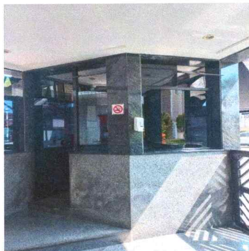
Figura 2: Portaria do Edifício Cidamar II
