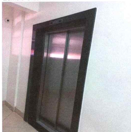
Figura 8: Porta do Elevador de Serviço do Edifício Cidamar II
