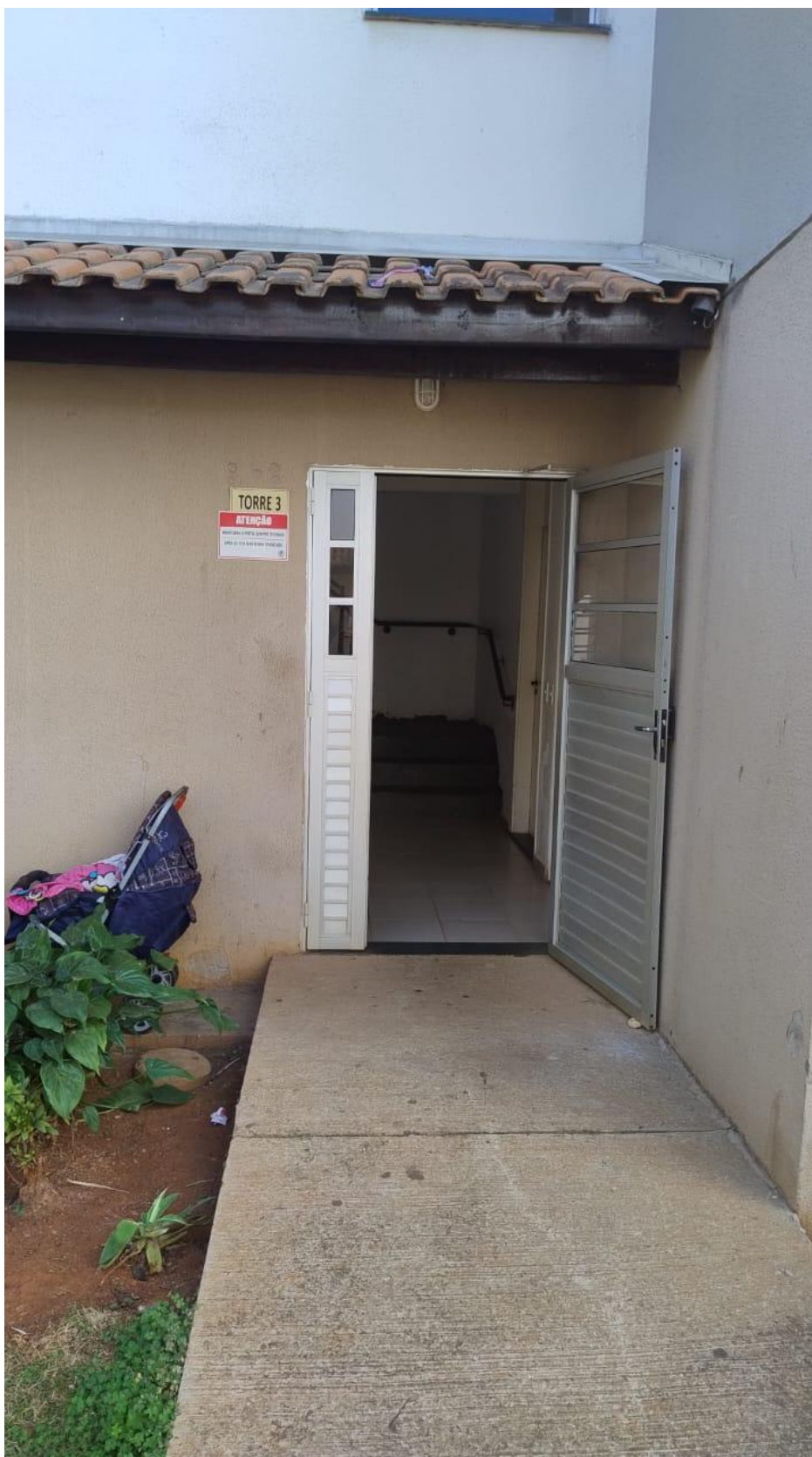
Foto 12 – Vista do acesso ao Bloco 3
