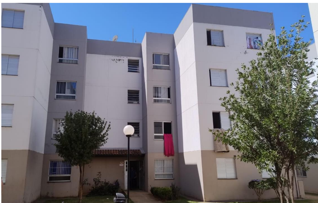
Foto 06 – Outra vista geral do Bloco 3
