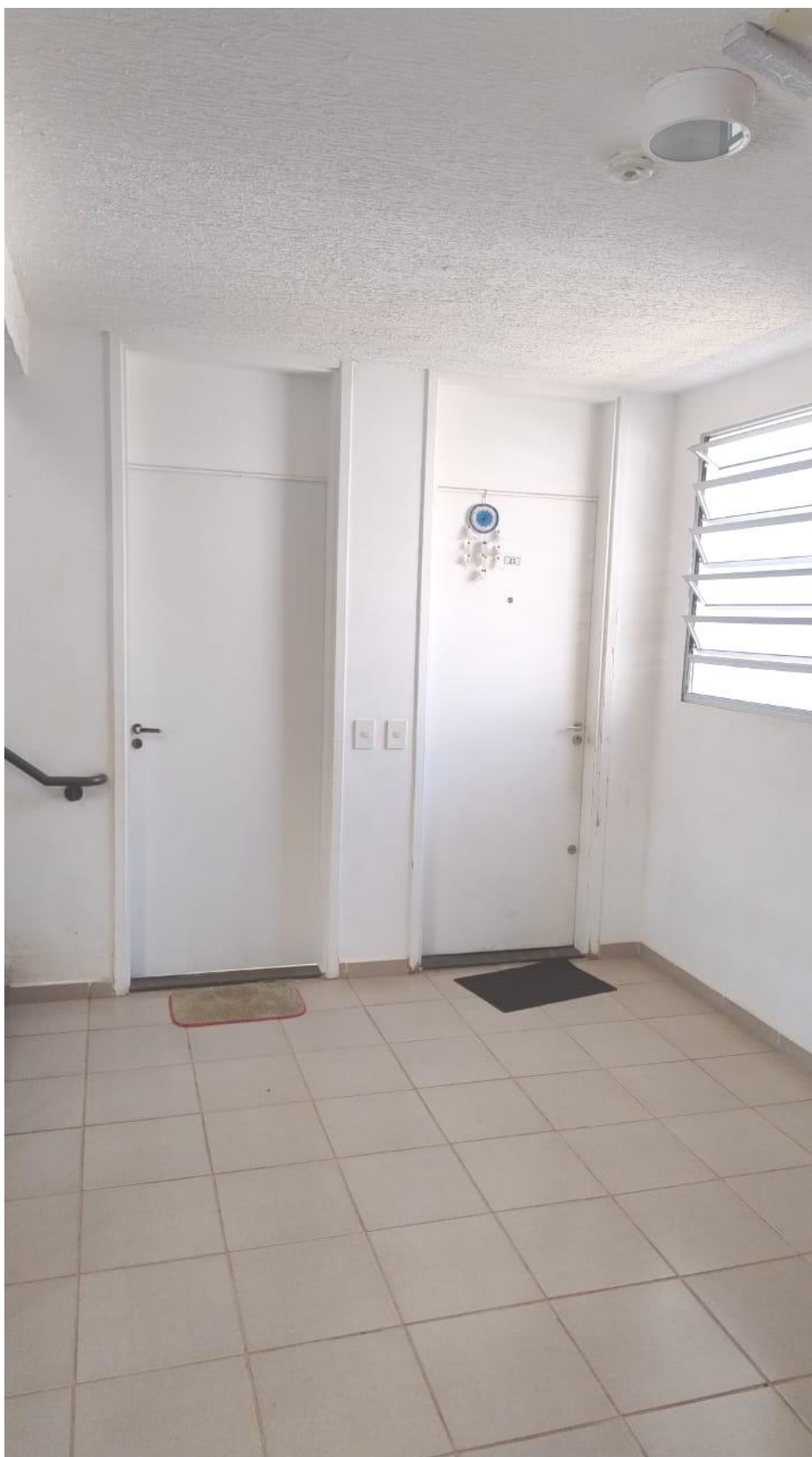
Foto 14 – Vista geral do hall de entrada do apartamento avaliando nº 22 (2º andar)
