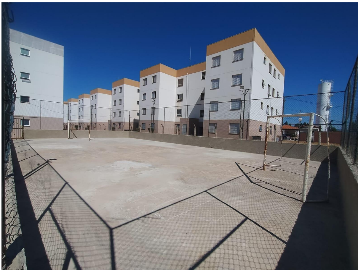
Foto 08 – Vista da quadra poliesportiva
