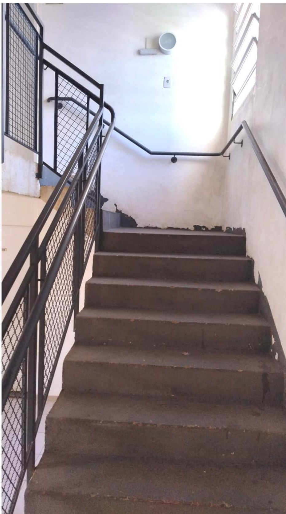
Foto 13 – Vista da escada de acesso ao imóvel avaliando (2º andar)
