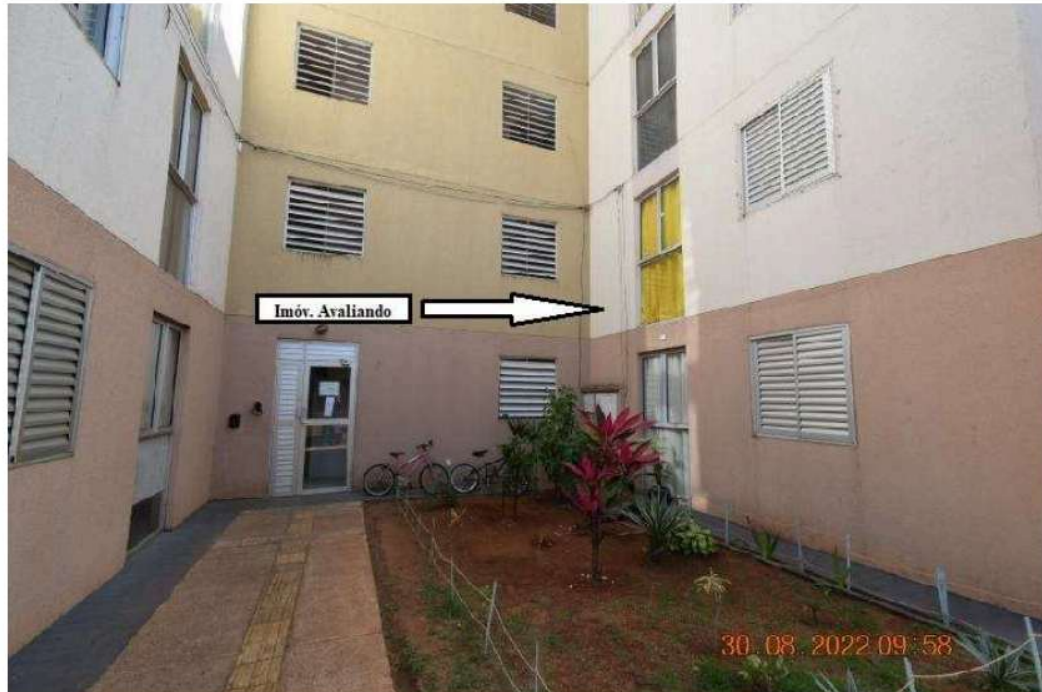
Vista externa do I.A e porta de acesso.
