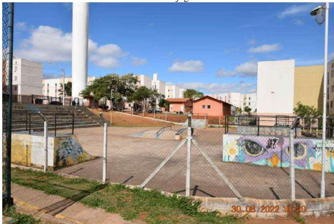
Pista para skates com arquibancada em concreto
