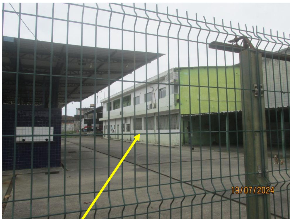
Foto 7 – Edificação com 2 pavimentos, tipo escritório, sobre o lote 14
