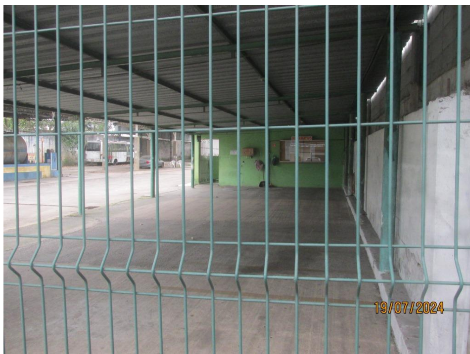
Foto 6 – Área frontal - Cobertura “A”, sobre o lote 14
