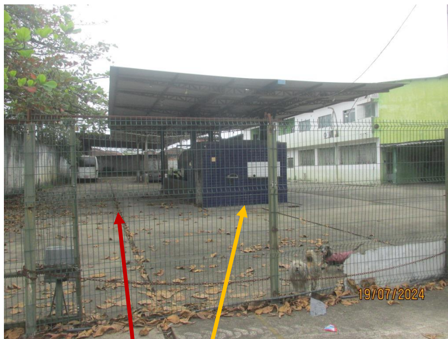
Foto 10 – Vista dos lotes 12 e 13 e das coberturas existentes sobre eles
