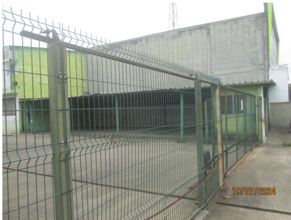
Foto 9 – Ainhamento da divisa frontal dos 3 lotes, totalmente fechada com gradil metálico
