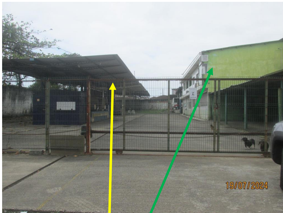
Foto 8 – Vista das coberturas “C”, “D” e “E” sobre os lotes 12 e 13 e da edificação com 2 pavimentos sobre o lote 14
