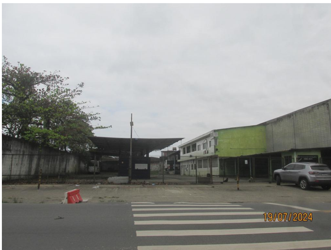
Fotos 1 e 2 - Vista frontal da área ocupada da requerida, voltada para Rua Frei Gaspar
