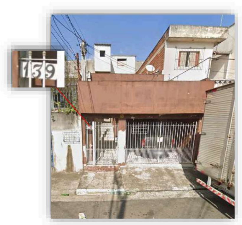
Fachada do imóvel em avaliação
