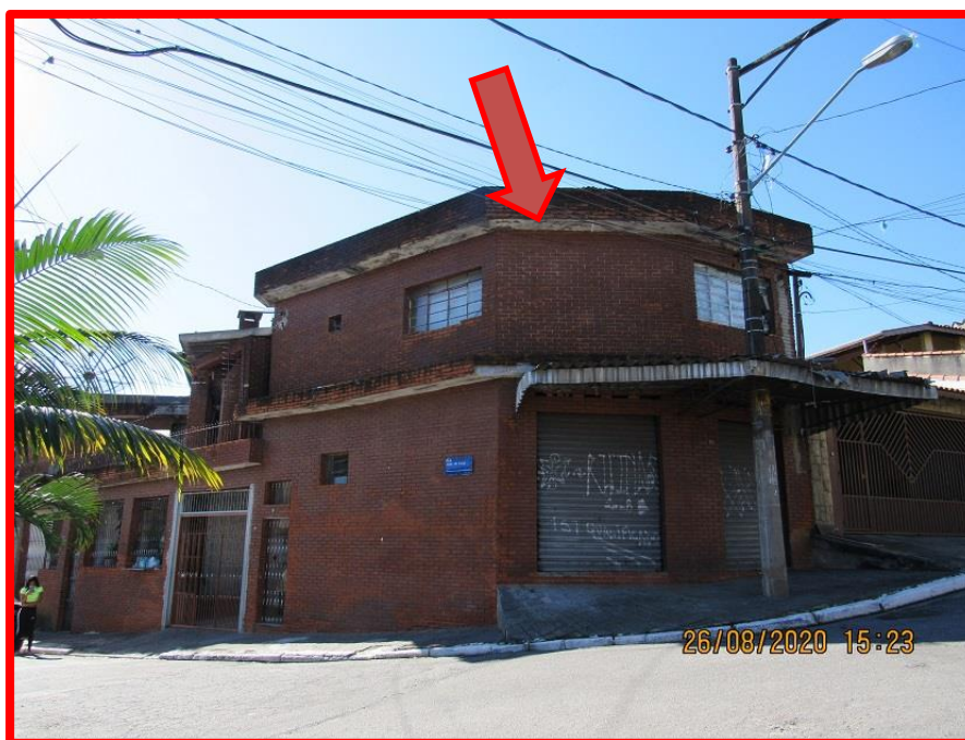
FOTO 03: Fachada do imóvel.
