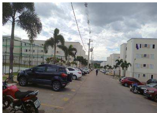
Foto 02: Vista parcial do condomínio
