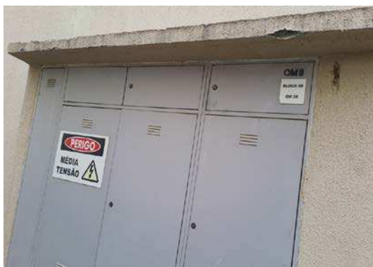
Foto 09: Relógio de energia do bloco 08
