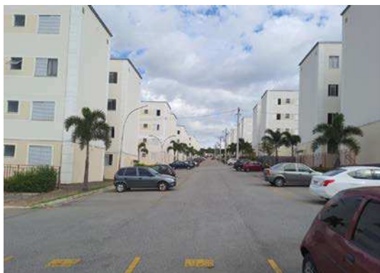
Foto 03: Vista parcial do condomínio
